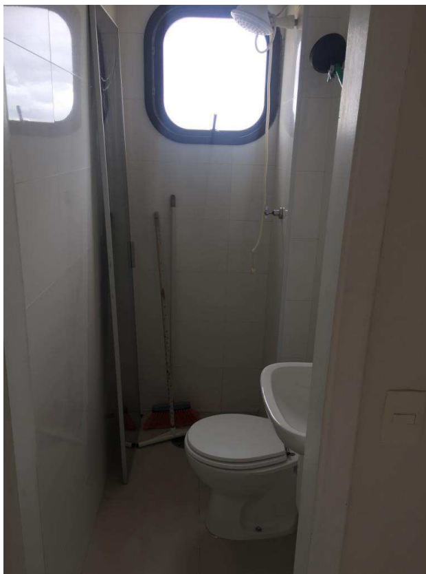
Foto 09 – Banheiro de empregada
