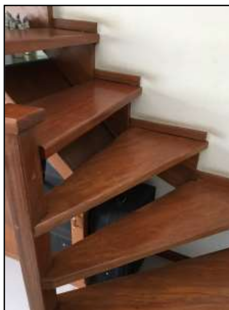
FOTO 27 : ACESSO AO PAVIMENTO SUPERIOR
