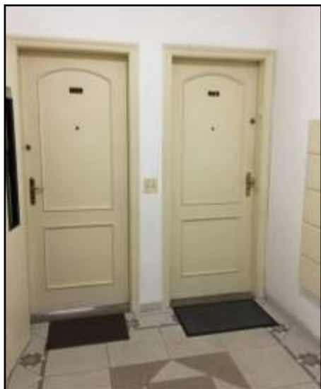
Foto 14 : HALL 12º PAVIMENTO
