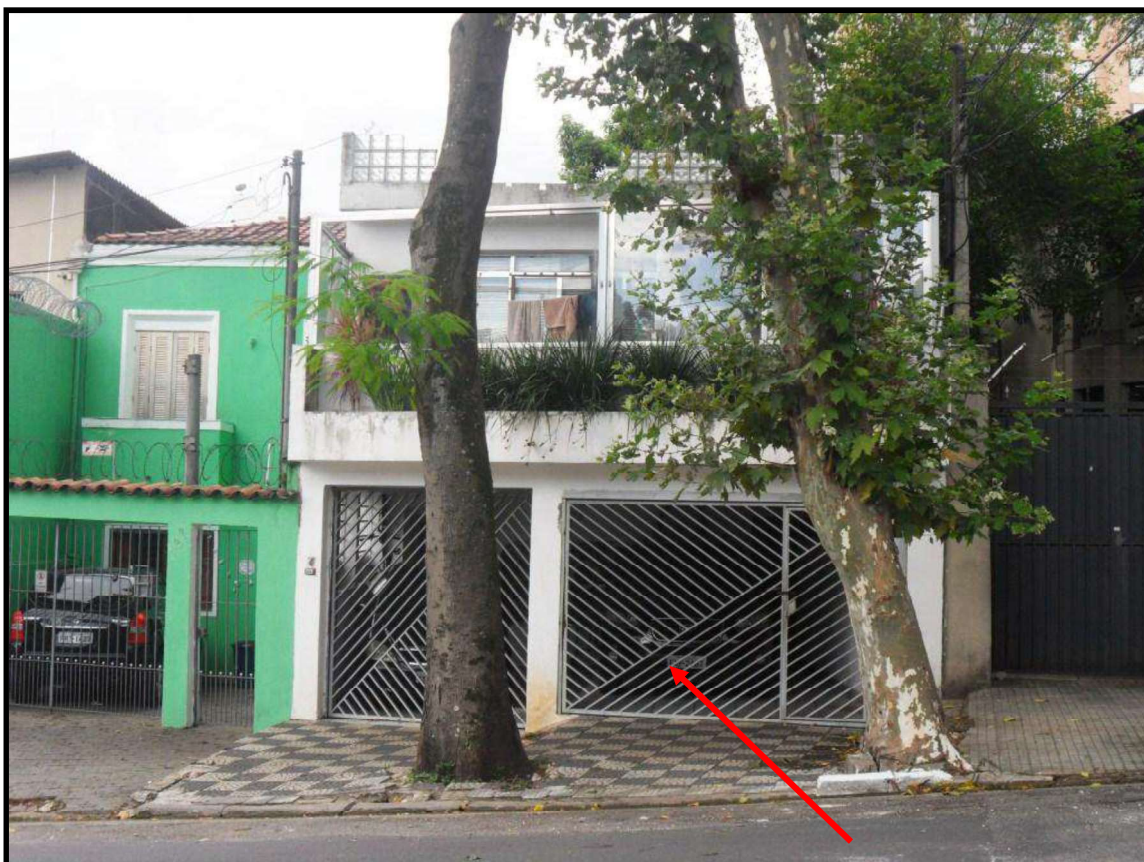
FOTO 01: Eis o imóvel avaliando, onde apontado.
