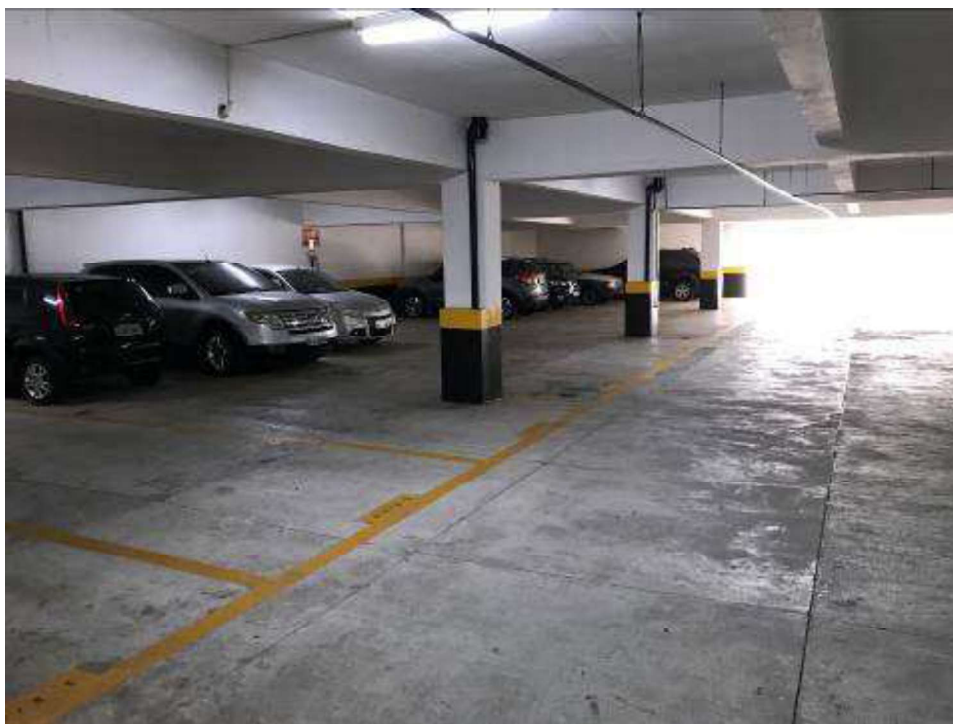
Vista parcial do 2º subsolo, o qual é destinado à garagem.
