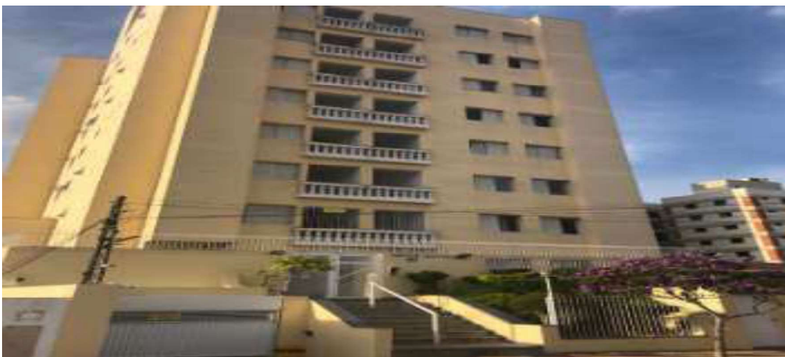
Fachada do prédio
