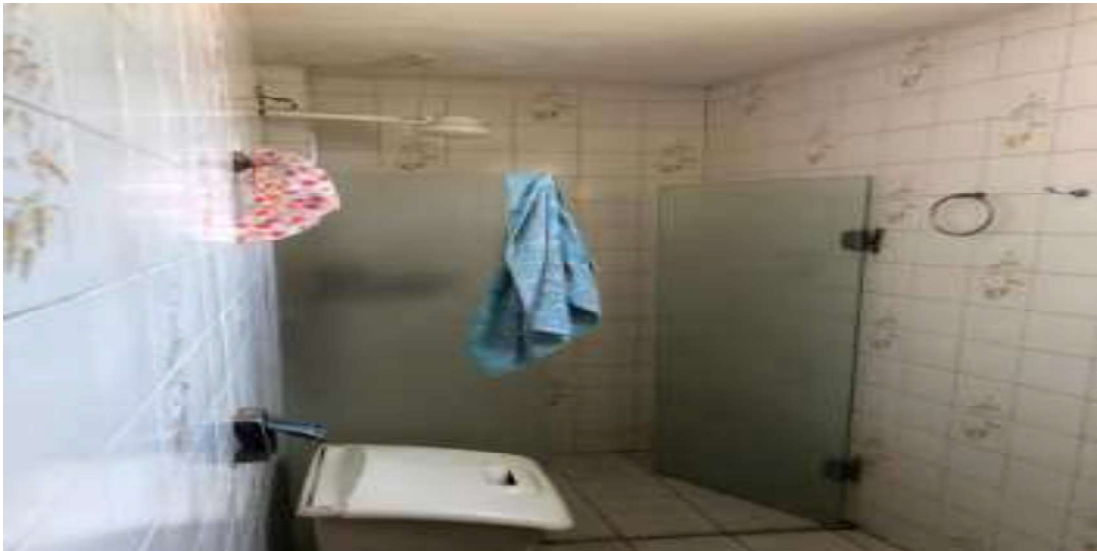
Amostra banheiro – apartamento 13
