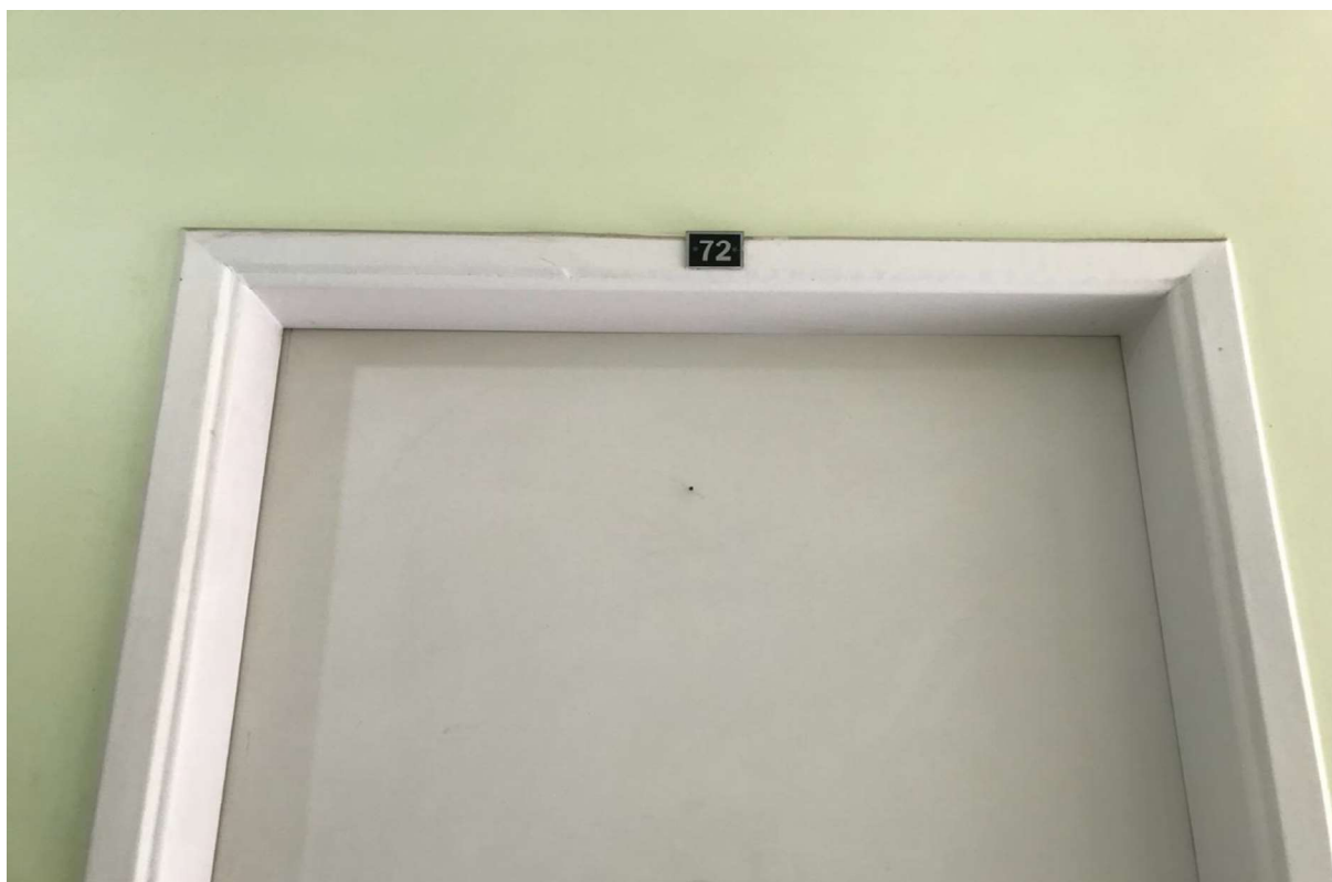
FOTO 10 – Vista da porta de entrada do imóvel avaliando.
