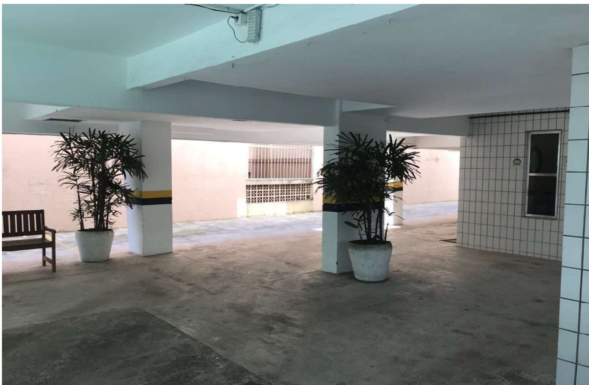
FOTO 08 – Vista parcial da garagem.
