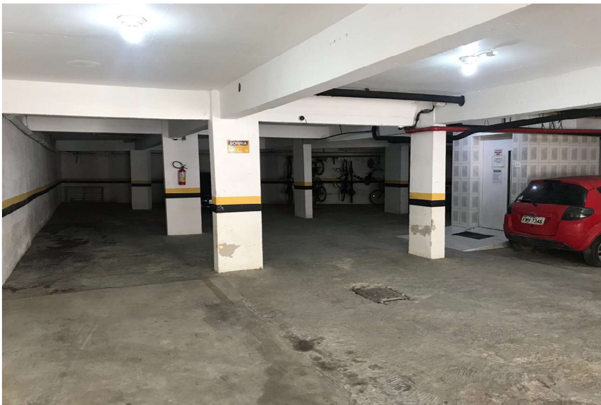
FOTO 07 – Vista parcial da garagem.
