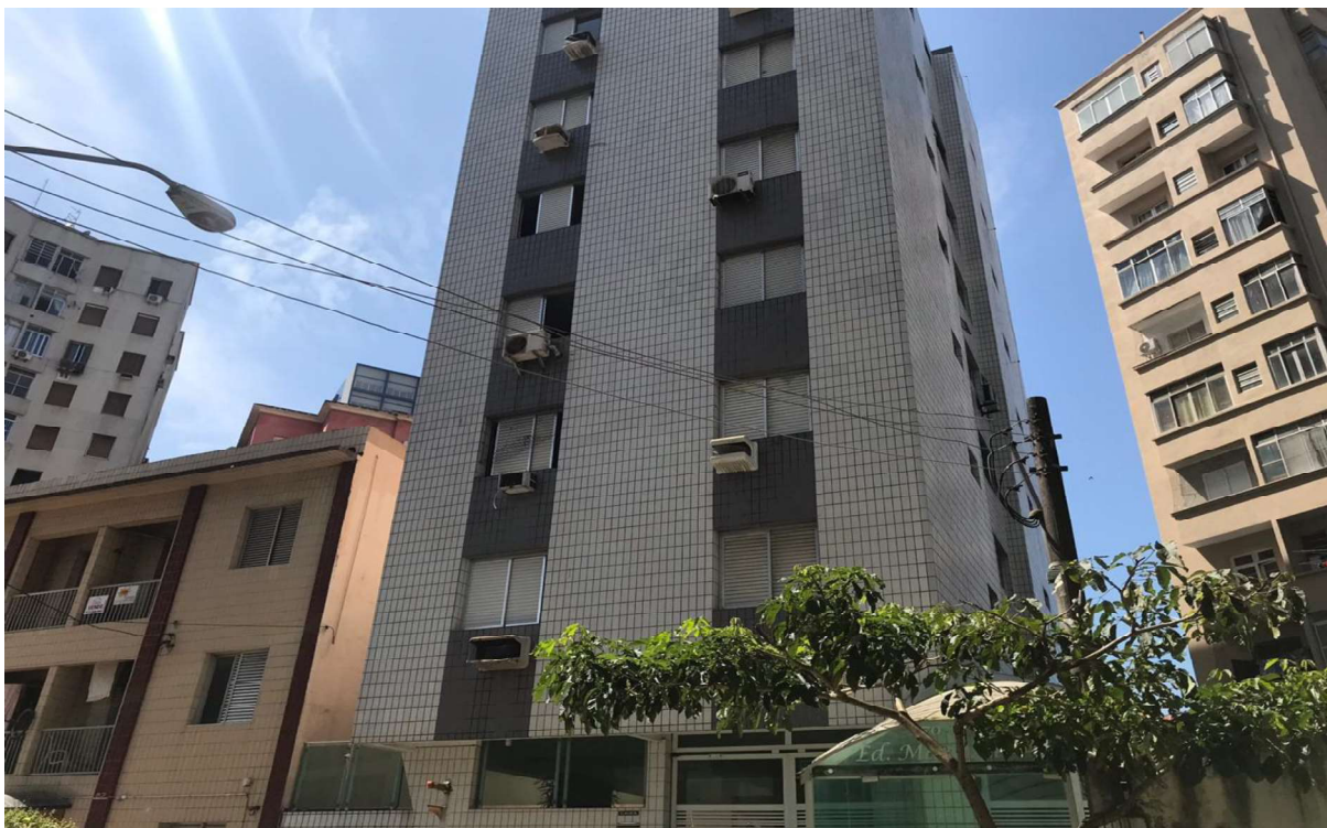
FOTO 03 - Vista parcial da fachada principal do imóvel avaliando (Edifício Marazul).
