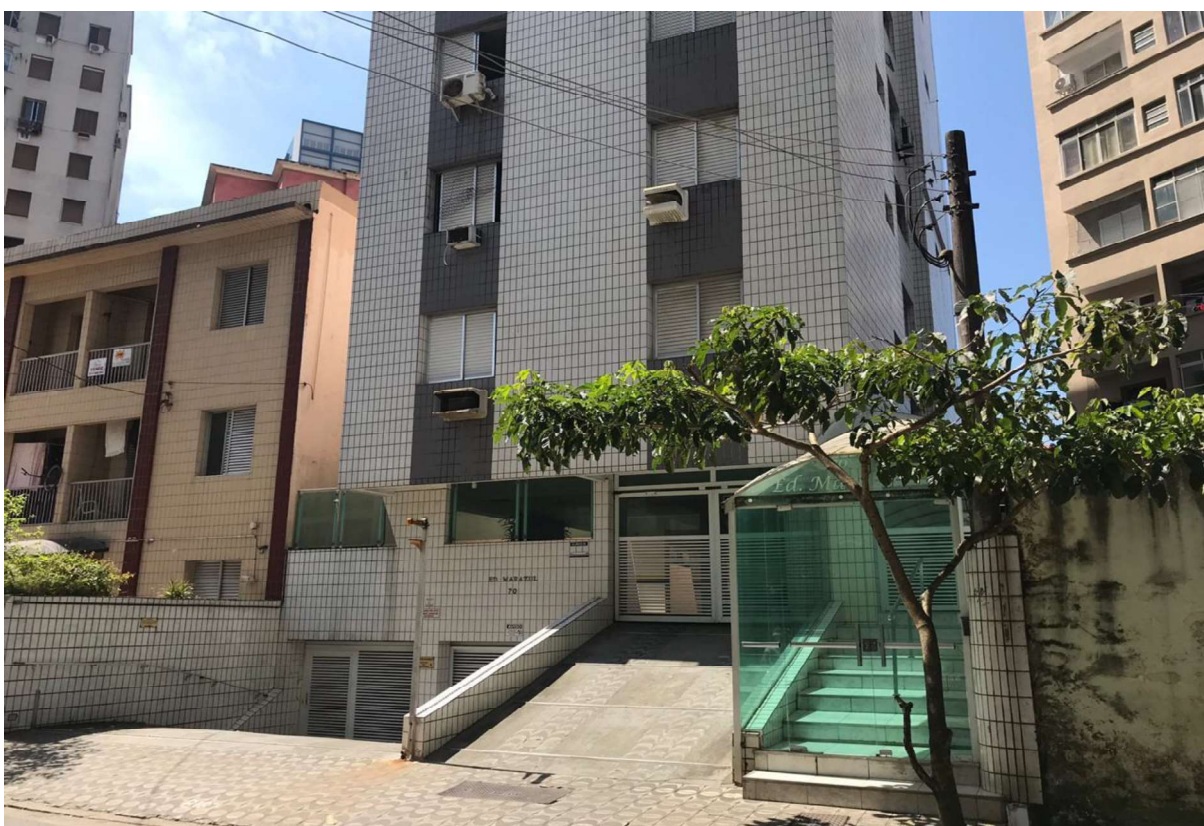
FOTO 04 - Vista parcial da fachada principal do imóvel avaliando (Edifício Marazul).
