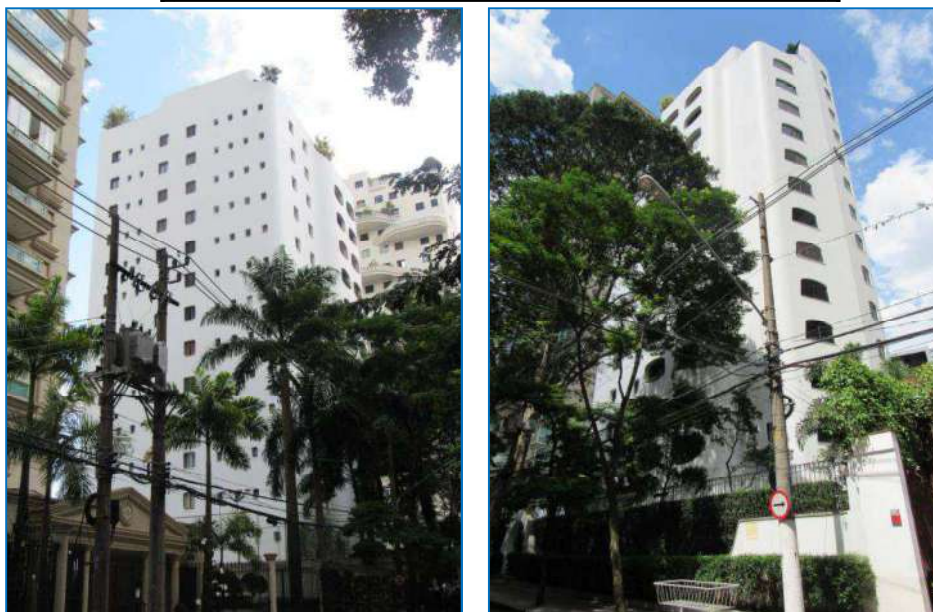
FACHADA DO EDIFÍCIO MARRAKESH.
