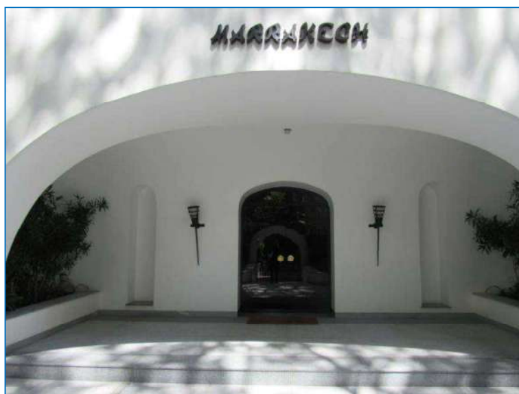
Foto de nº 10 - Acesso ao Edifício Marrakesh.
