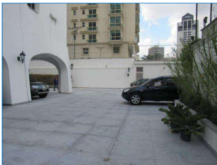
Foto de nº 12 - Áreas de circulação e vagas de estacionamentos, no térreo.
