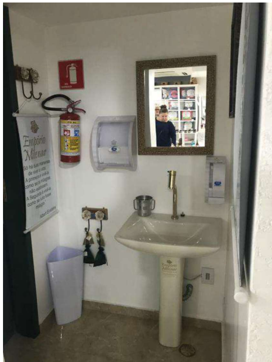
Vista do lavatório da loja.
