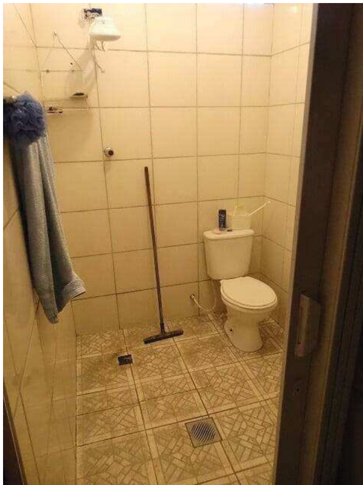
FOTO N o 5 - Vista do banheiro interno.
