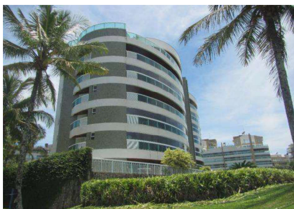
Fachada do edificio
