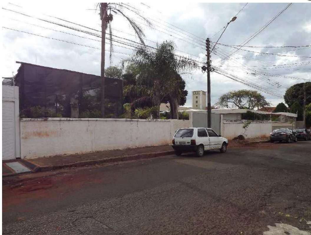
Imagem 7 - Vista anterior do imóvel avaliando
