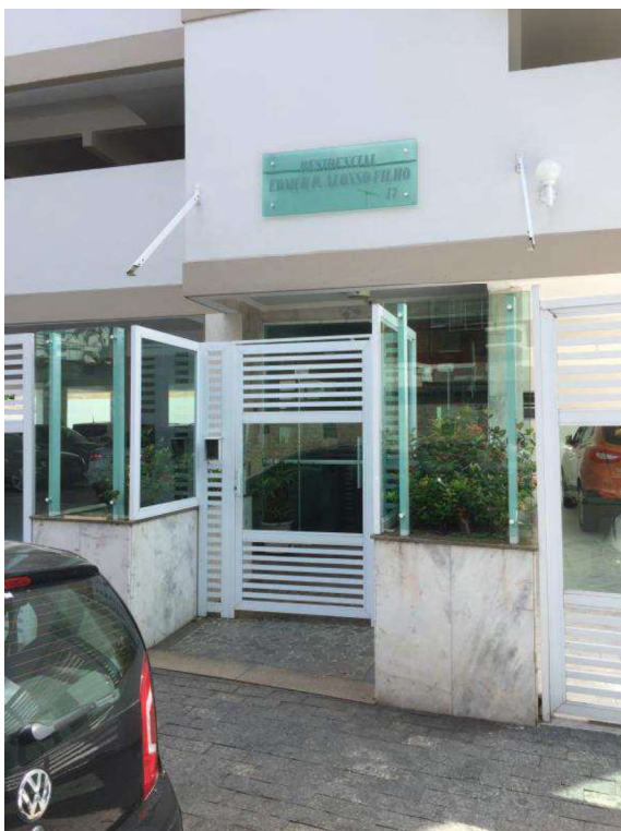
Figura 5: Vista do acesso social.
