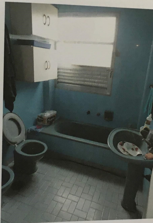
VISTA DO PRIMEIRO BANHEIRO.
