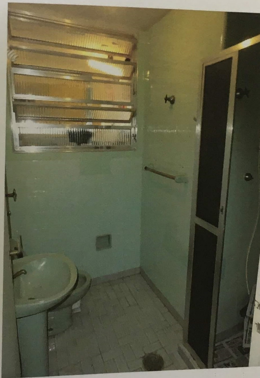
VISTA DO SEGUNDO BANHEIRO.
