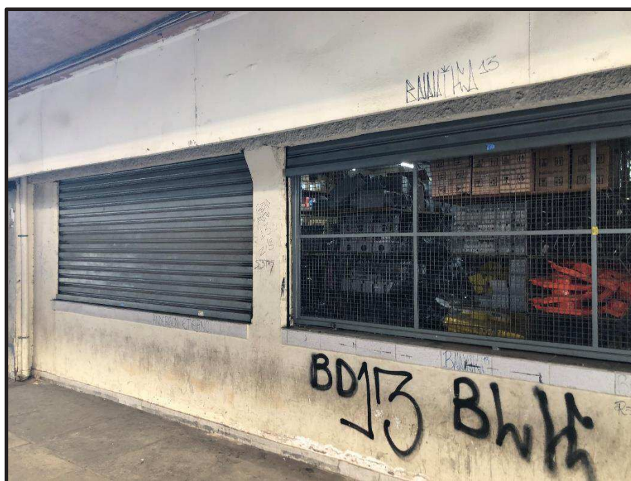
Foto 12 – Loja 23 – Fachada – 1º pavimento – Vista 1
