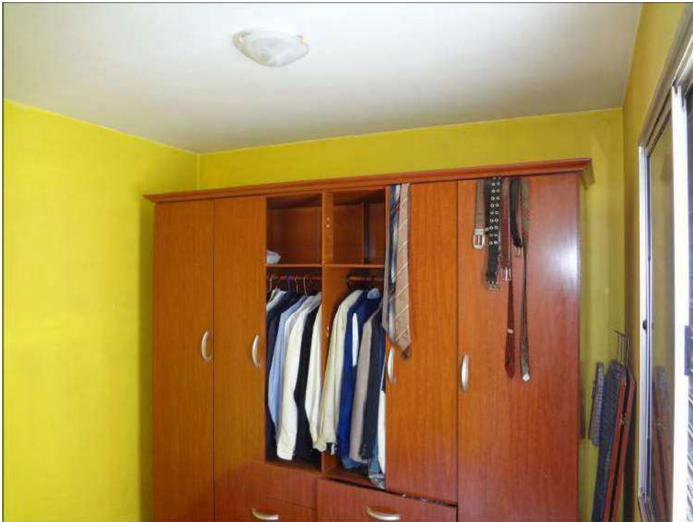
Foto 19 – Dormitório 1, destaque para a laje de forro.
