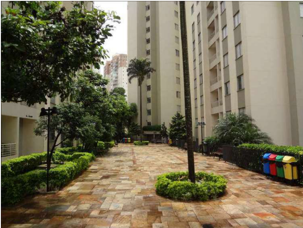
Foto 25 – Pátio interno do Condomínio.
