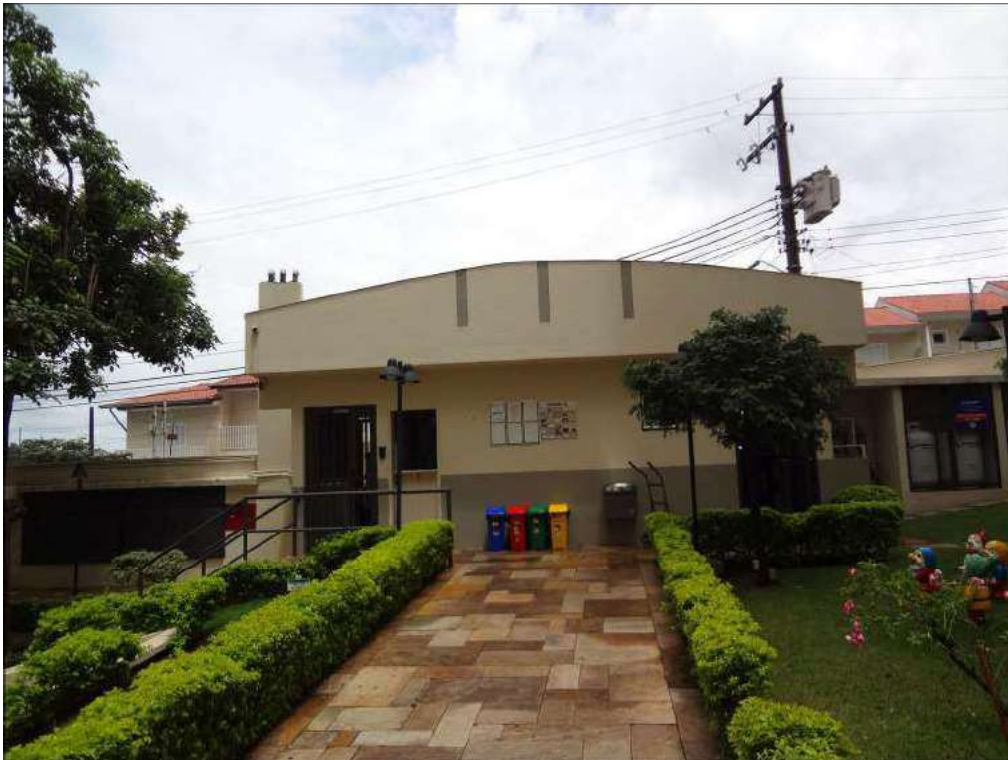
Foto 23 – Portaria, observador dentro do condomínio.
