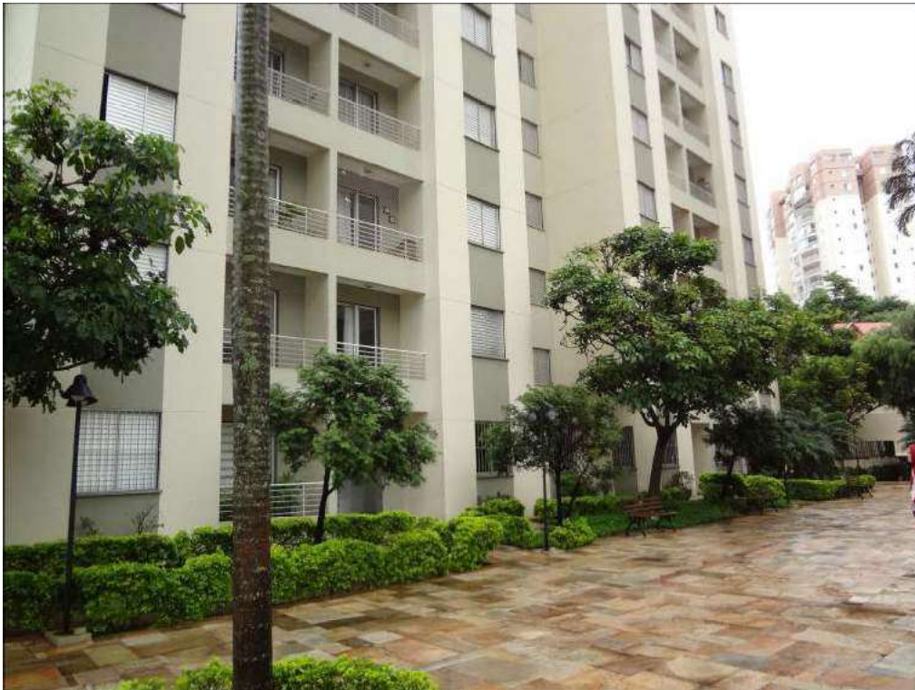
Foto 3 - Bloco B - Edifício Begônia, onde está inserido o APARTAMENTO nº 93.
