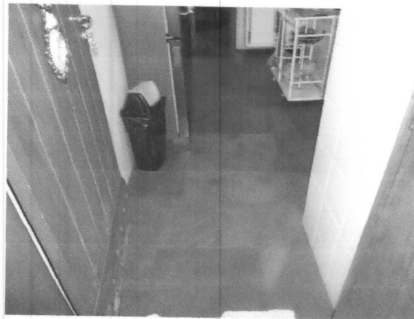
Figura 6 – piso de pedra polida (em toda a construção)
