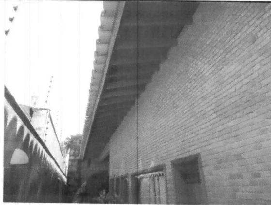
Figura 4 – beiral com 1,00 metro em madeira ipê, existente em toda a edificação
