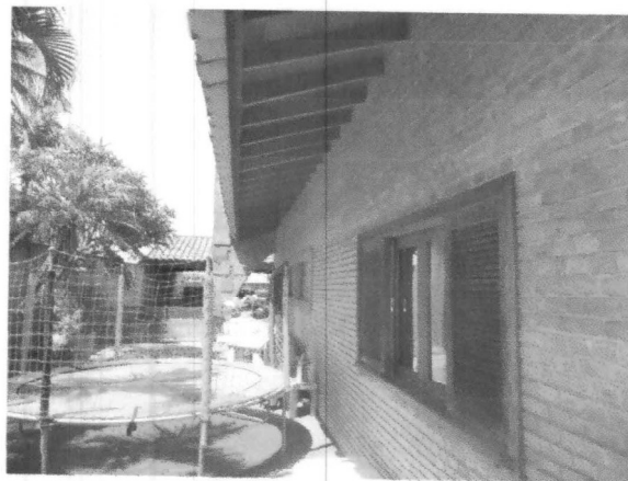
Figura 5 – janelas em madeira maciça ipê.
