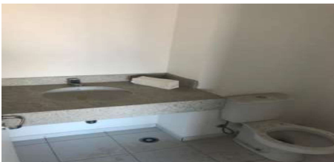
Banheiro interno – sem acabamento
