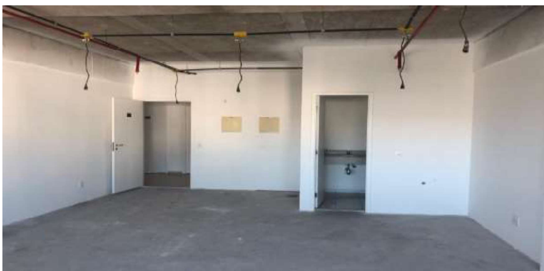
Visão ampla da sala – sem acabamento
