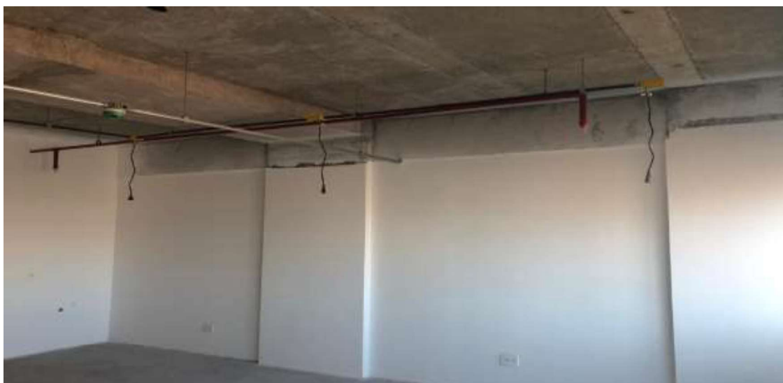
Visão interna- Teto e instalações – sem acabamento
