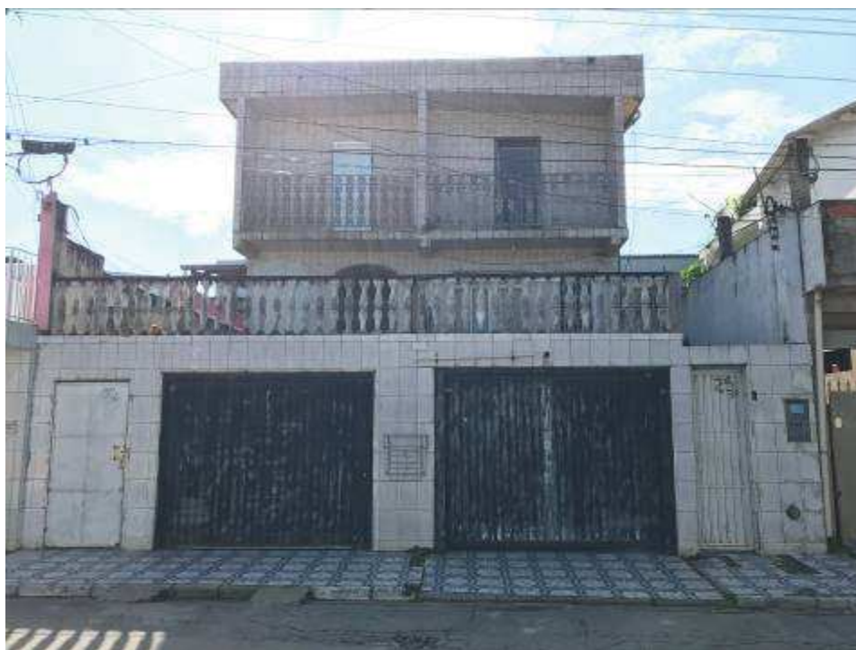
Aspectos da fachada do imóvel.
