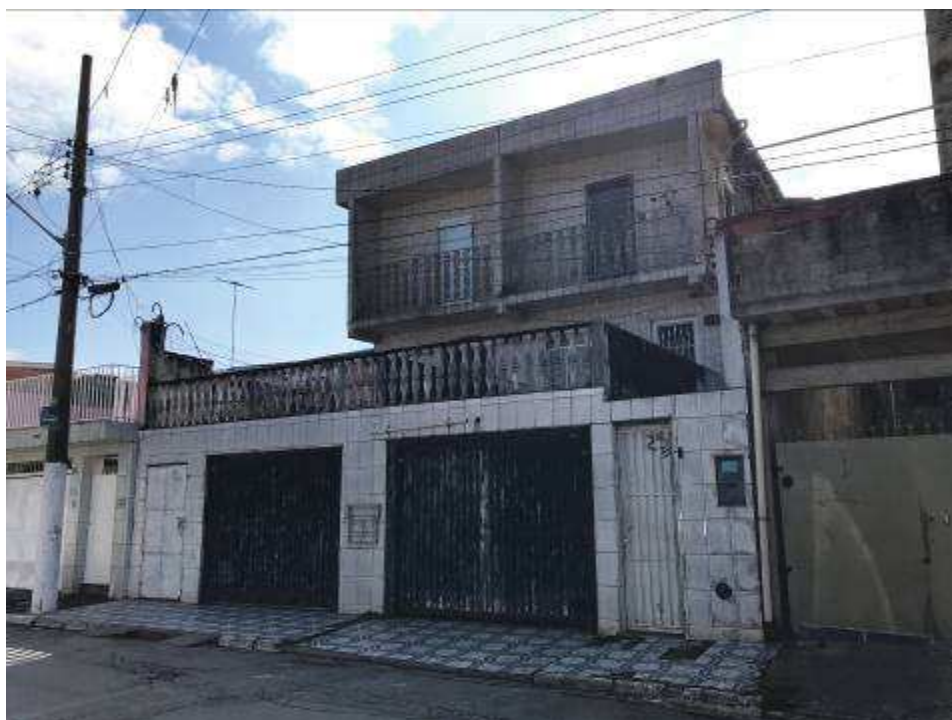
Fachada do imóvel avaliando, visto da Rua Forte de Santo Antônio.
