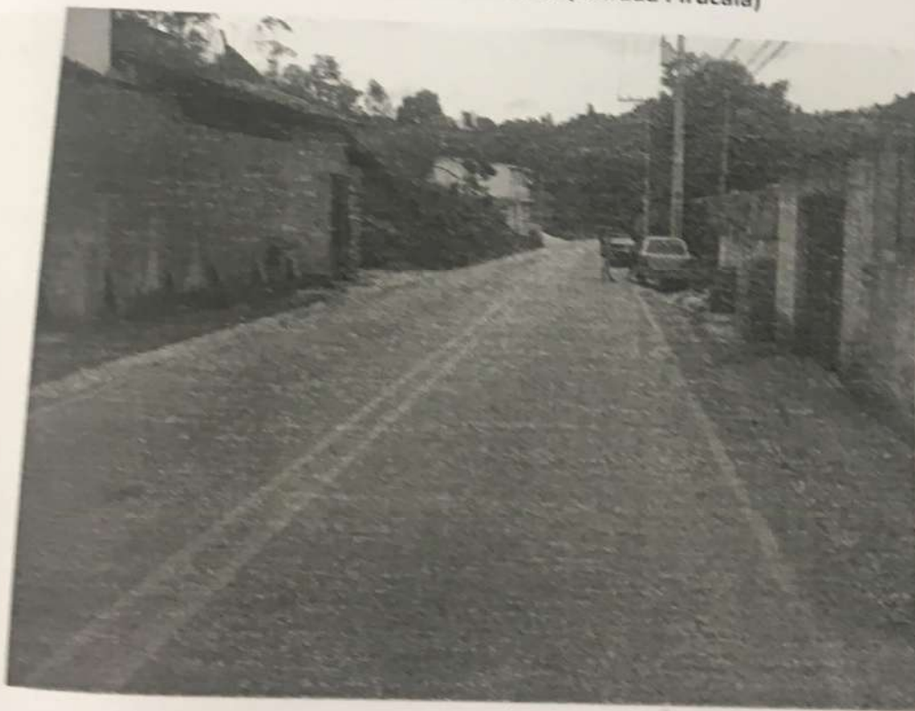
Foto Vista Frente dos Lotes 10 e 11 da Quadra 15 do Loteamento Recanto Céu Azul - Estrada Norberto Antonio de Moraes (Estrada Pirucaia)
