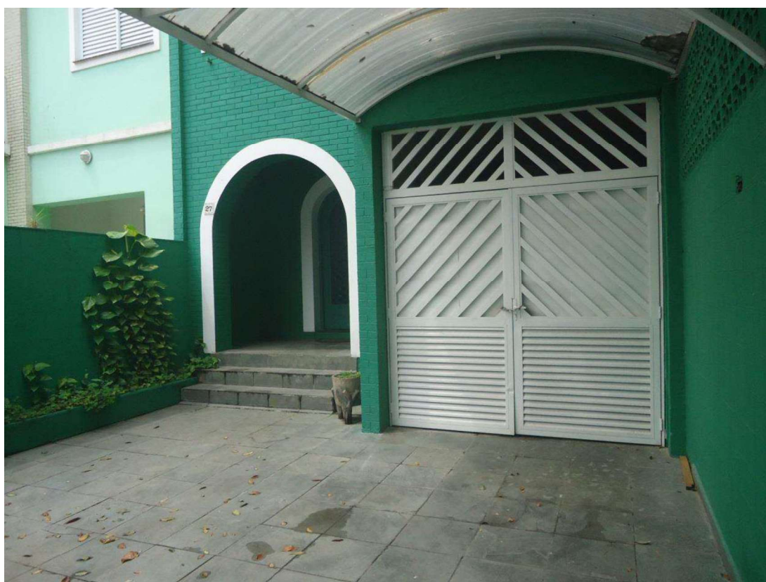
FOTO 05 :-Vista da entrada e garagem do imóvel.
