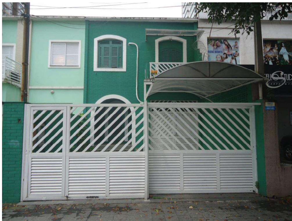
FOTO 02 :-Vista do imóvel.
