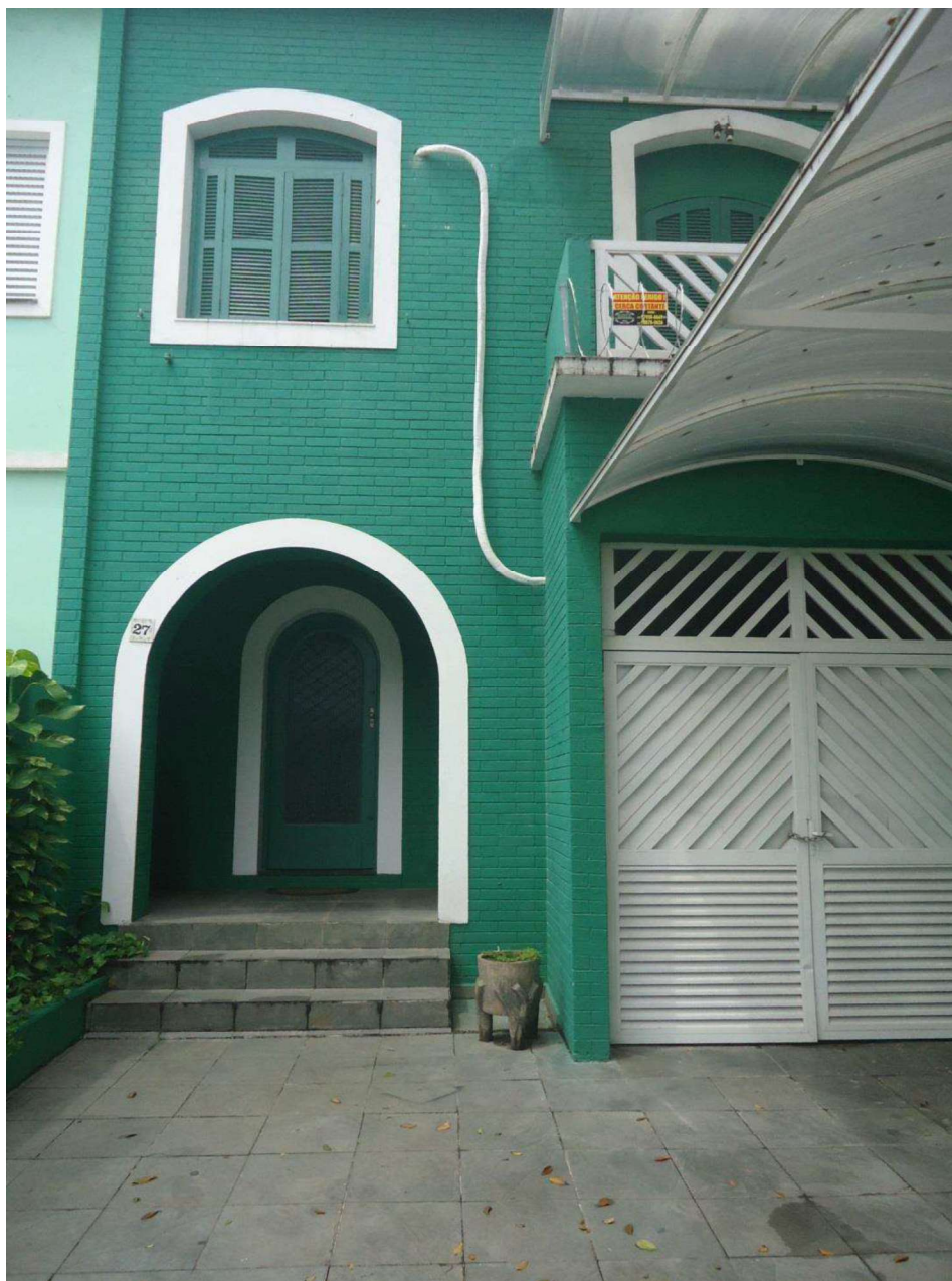
FOTO 06: - Vista da entrada do imóvel.
