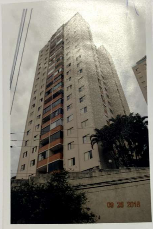
VISTA DA FACHADA DO BLOCO "C" - EDIFÍCIO SOLAR DOS FLAMBOYANT'S, INTEGRANTE DO "CONJUNTO MORADAS DA CANTAREIRA", ONDE SE LOCALIZA O APARTAMENTO AVALIANDO.
