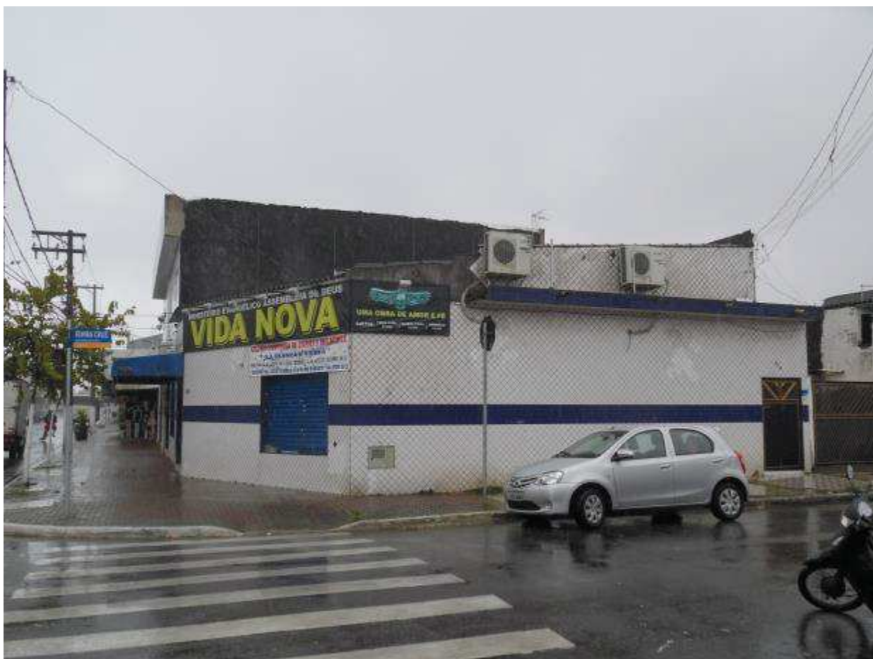
FOTO 01:- Vista do logradouro Rua Elvira Cruz Leal e fachada do imóvel.
