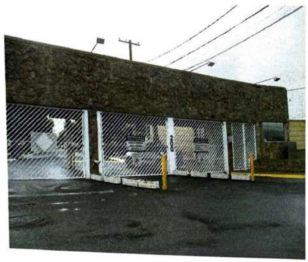
Foto 1 – Vista frontal do Cond. Res. Portal dos Pinheiros (Portaria) - Rua Doutor Paulo de Pinho Monteiro, nº 200
