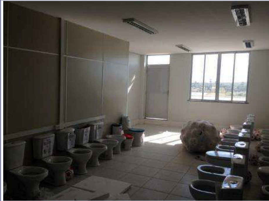
SALA NA ADMINISTRAÇÃO (2º PAVIMENTO)
