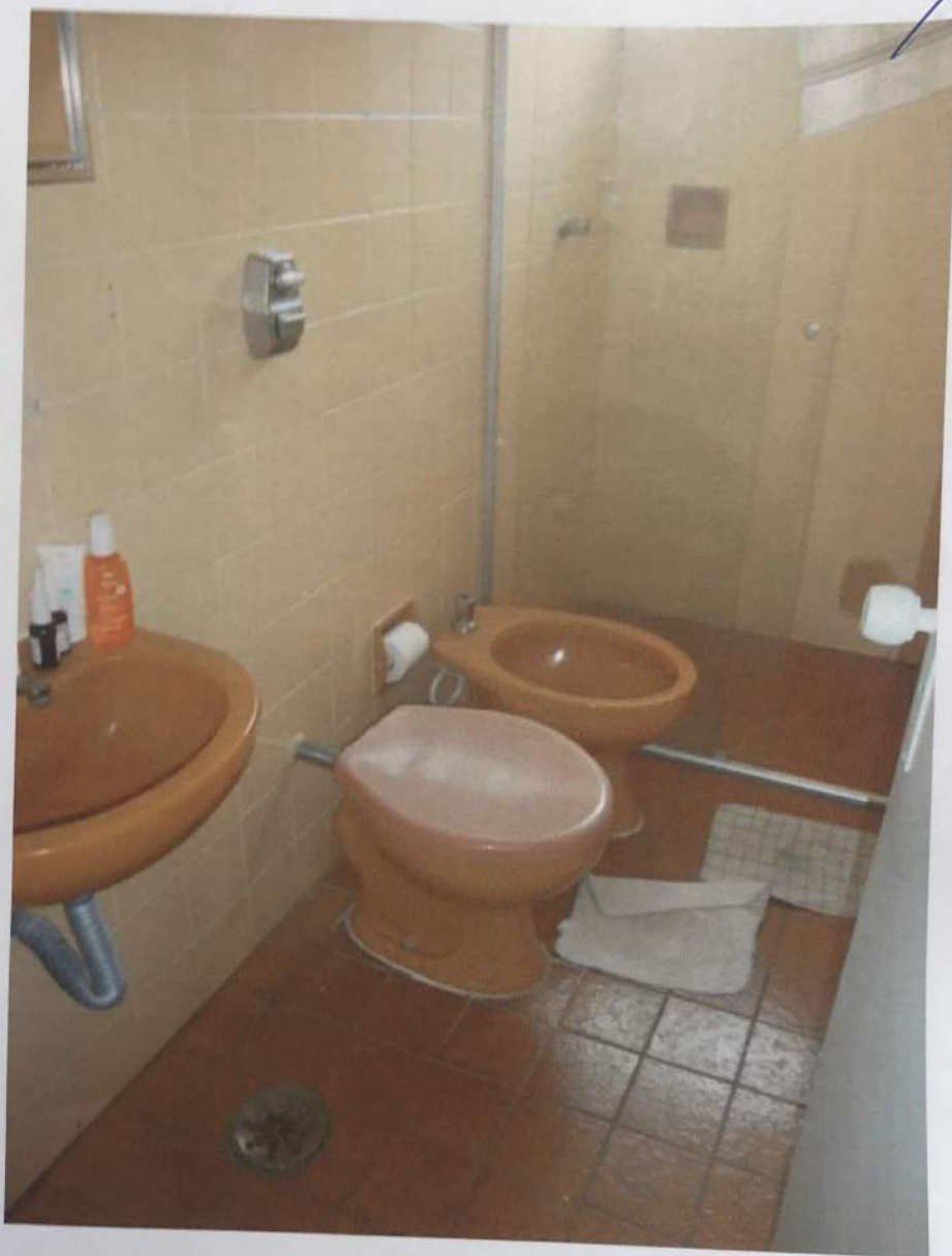
Fotografia 11: Vista parcial acerca do imóvel avaliado.
