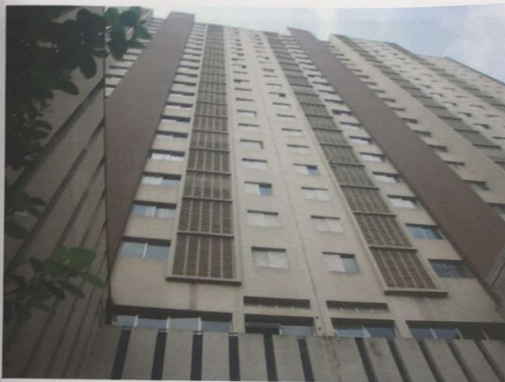
Fotografia 03: Vista parcial da fachada do Edifício São Luiz Plaza.
