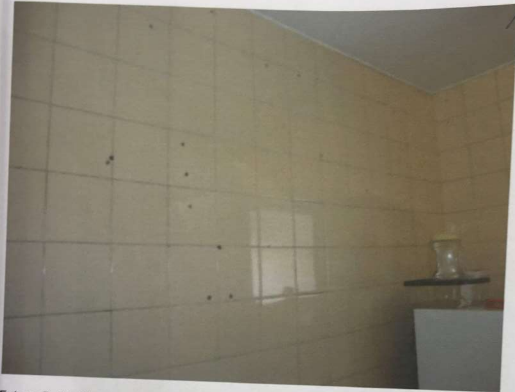
Fotografia 10: Vista parcial acerca do imóvel avaliado.
