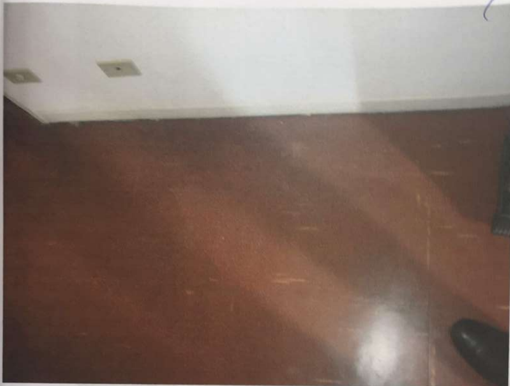
Fotografia 16: Vista parcial acerca do imóvel avaliado.
