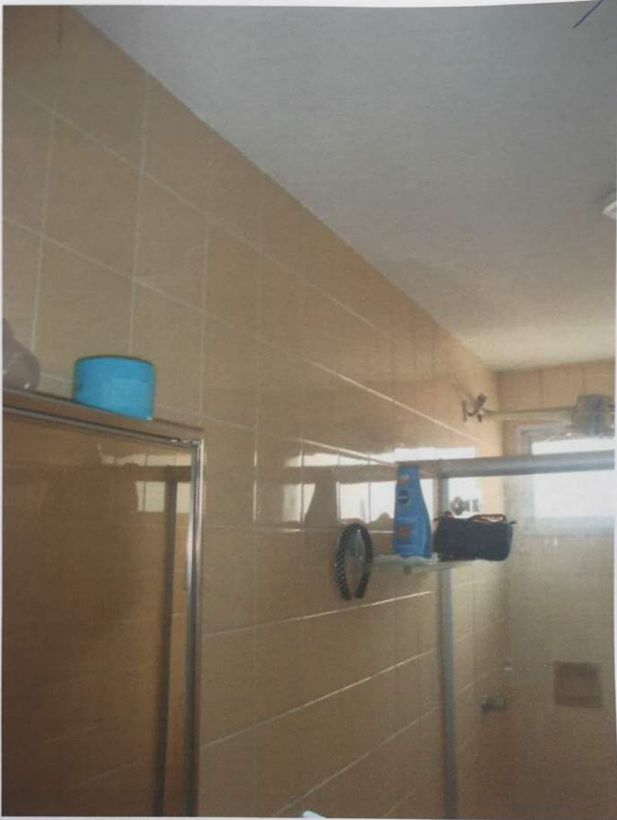
Fotografia 12: Vista parcial acerca do imóvel avaliado.
