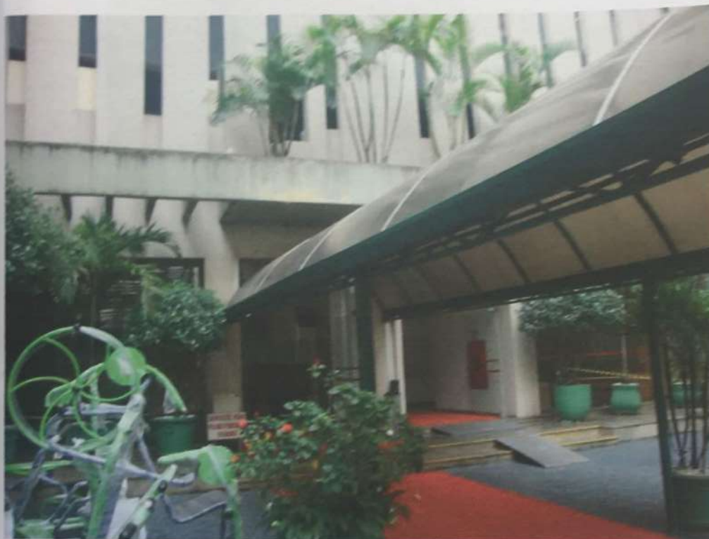
Fotografia 01: Vista parcial da fachada do Edifício São Luiz Plaza.
