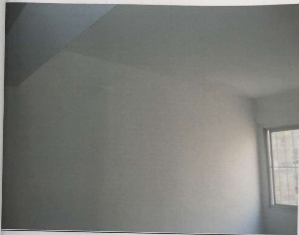
Fotografia 04: Vista parcial acerca do imóvel avaliado.
