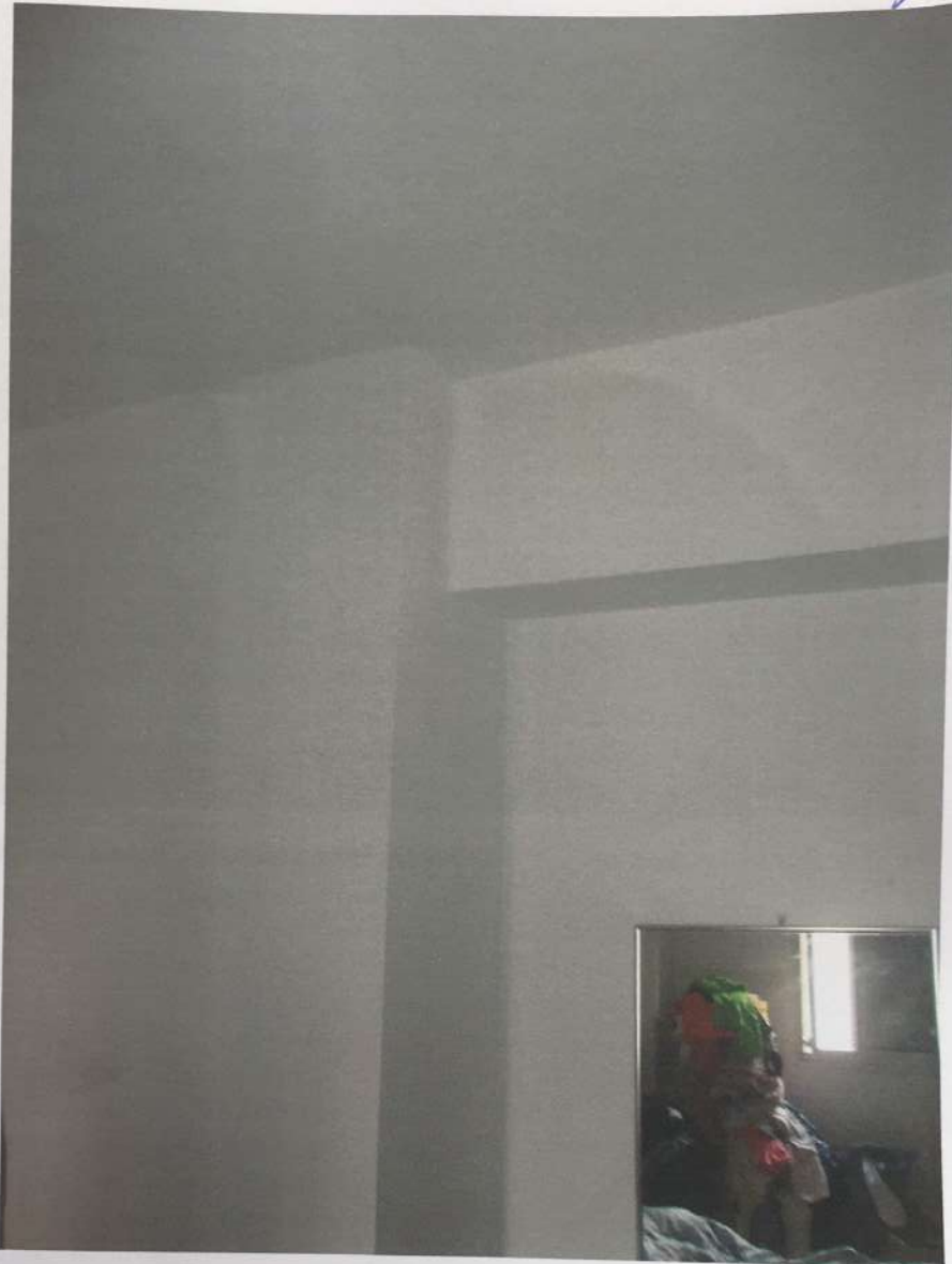
Fotografia 15: Vista parcial acerca do imóvel avaliado.
