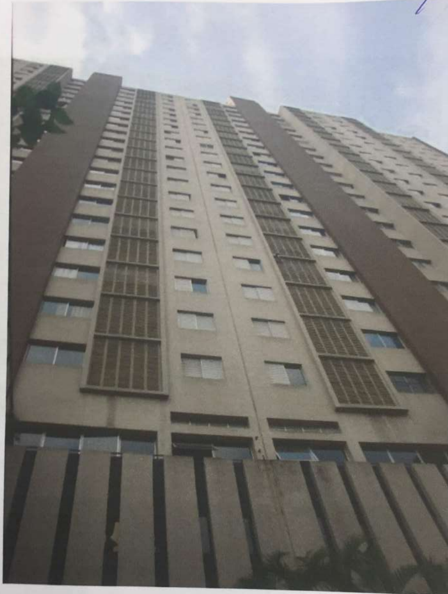
Fotografia 02: Vista parcial da fachada do Edifício São Luiz Plaza.
