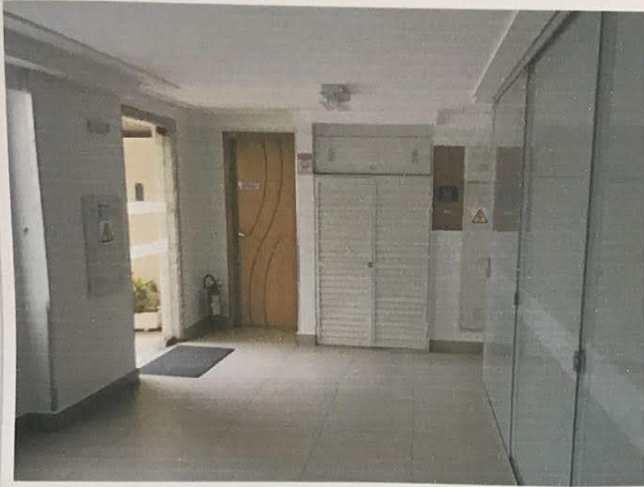
Foto nº 30 - Outra vista do pavimento térreo do bloco nº 10, vendo-se, ao fundo, a porta da sala de funcionários, e, à esquerda, outra saída para a parte externa desse bloco.
