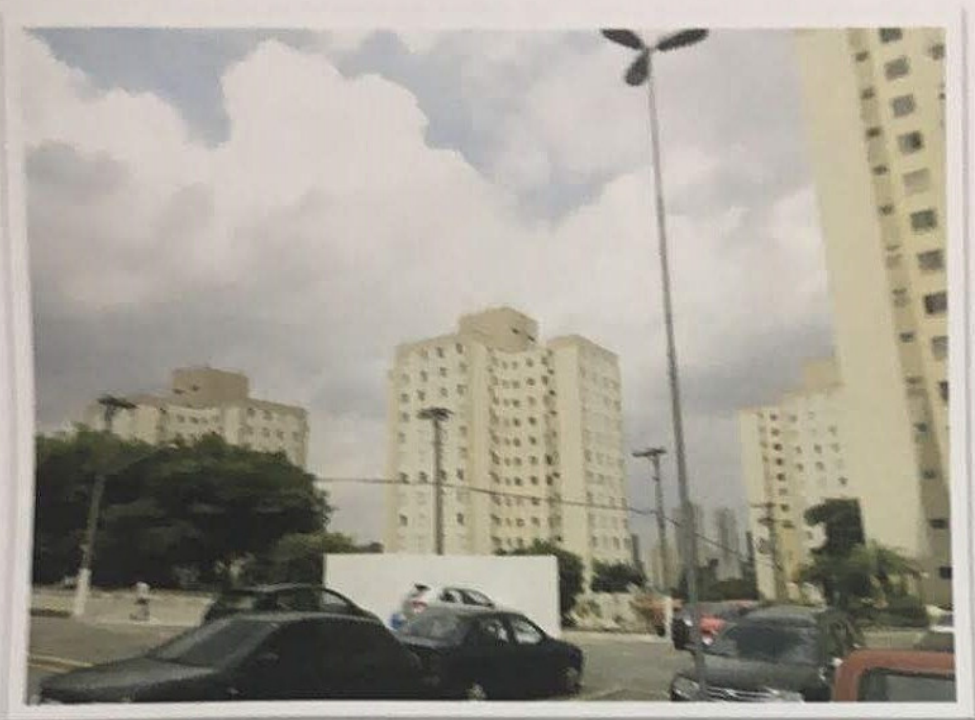
Foto nº 14 - Outra vista do condomínio, podendo-se observar as vagas de garagem que, sem exceção, são descobertas e no pavimento térreo de cada bloco.
