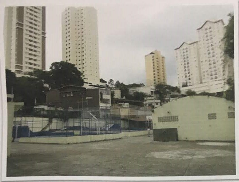
Foto nº 10 - Vista parcial das quadras poliesportivas e galpão na parte baixa do condomínio.
