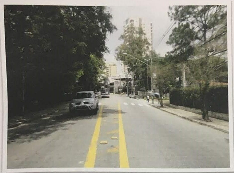
Foto nº 4 - Vista da Avenida Parada Pinto, no trecho em consideração, que tem tráfego intenso nos dois sentidos de trânsito.
