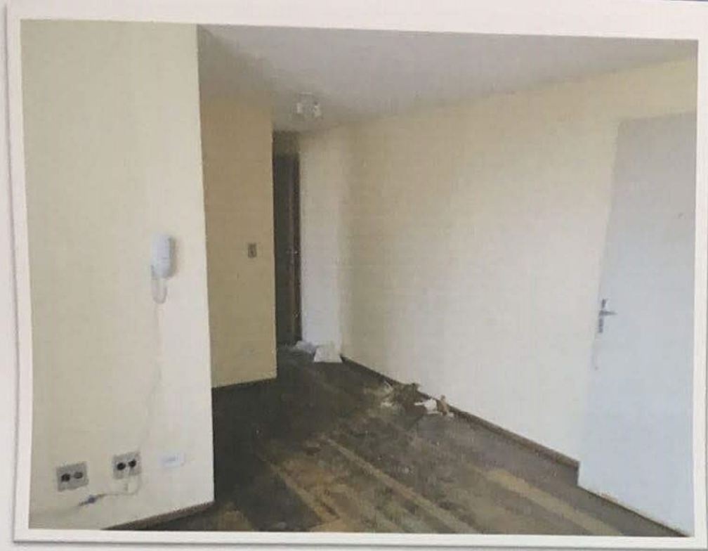
Foto nº 38 - Vista mais afastada em relação a fotografia anterior, vendo-se, parcialmente, a sala de jantar, como denominado na planta baixa no Anexo 2.
