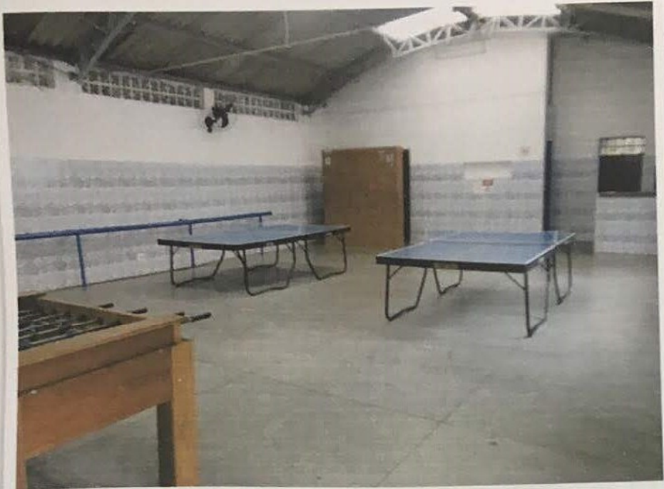
Foto nº 12 - Vista parcial do galpão.
