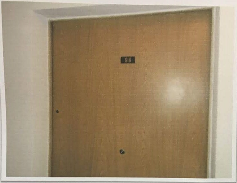
Foto nº 32 - Vista parcial do apartamento avaliando sob o nº 96, que não foi vistoriado pelas razões retro expostas.
