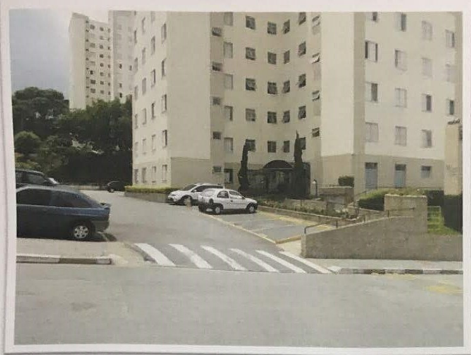
Foto nº 20 - Vista do acesso ao bloco nº 10.
