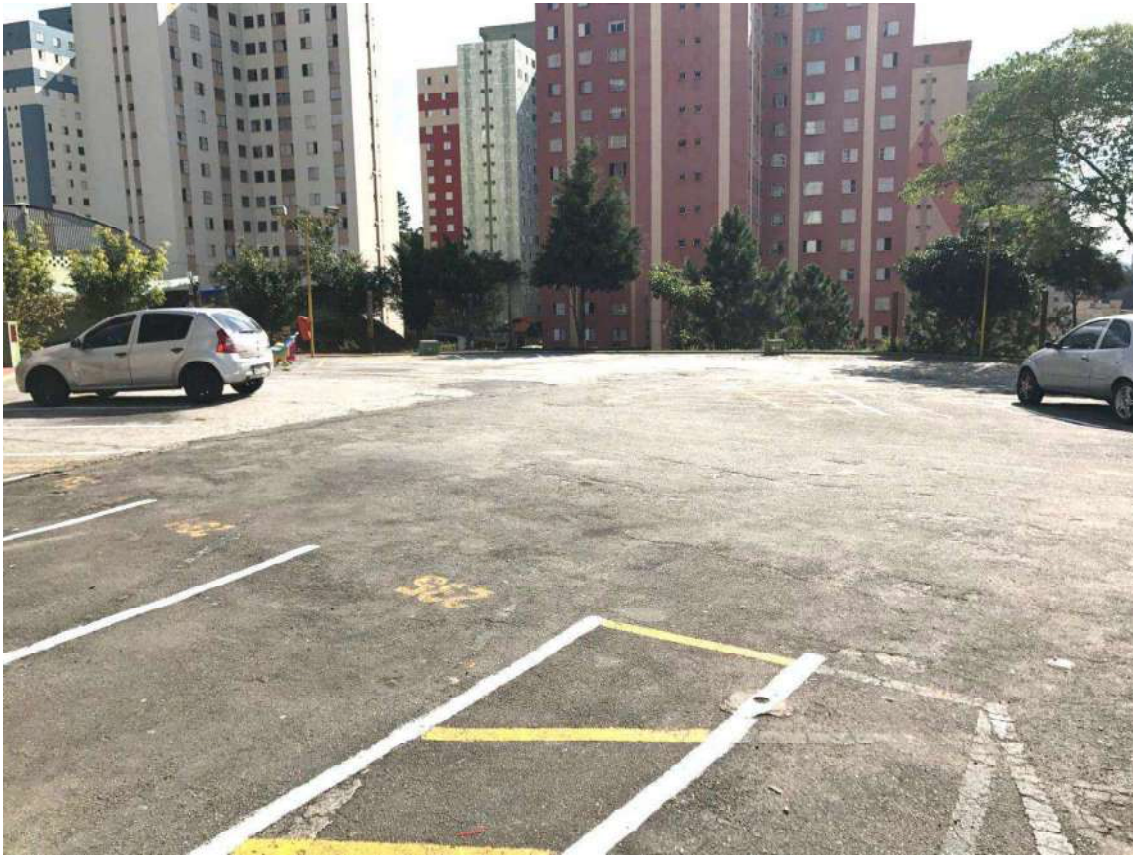
FOTO 31 : Vista do pátio para eventos abertos.
