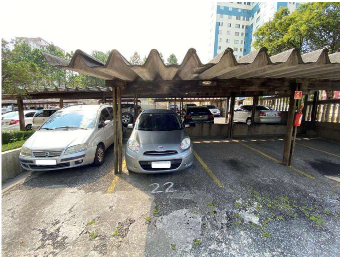
Foto 21: Vista da vaga pertencente ao apartamento nº22.
