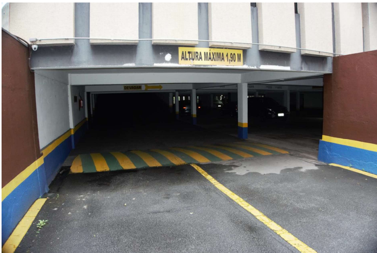
Foto 3. Entrada para o estacionamento.
