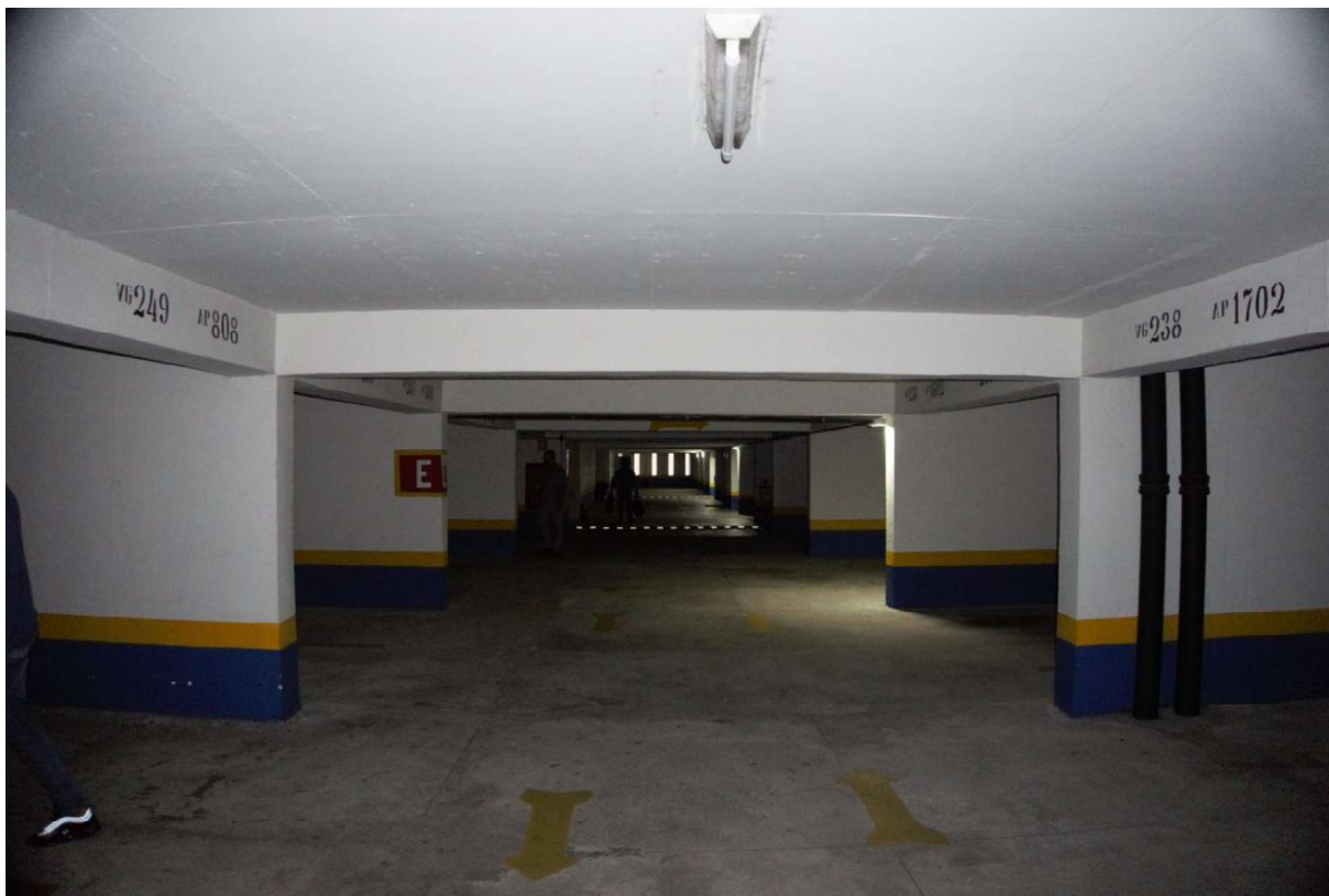
Foto 4. Estacionamento, acesso para a vaga.
