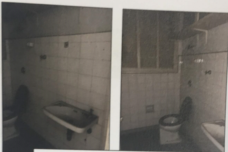
Vista do banheiro do conjunto
