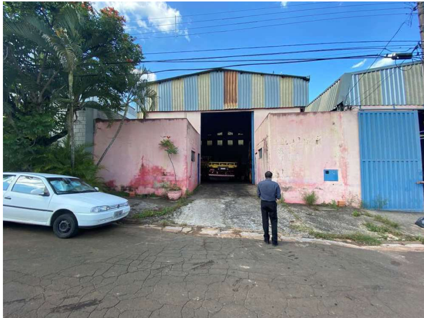
VISTA DA ENTRADA DO IMÓVEL.
