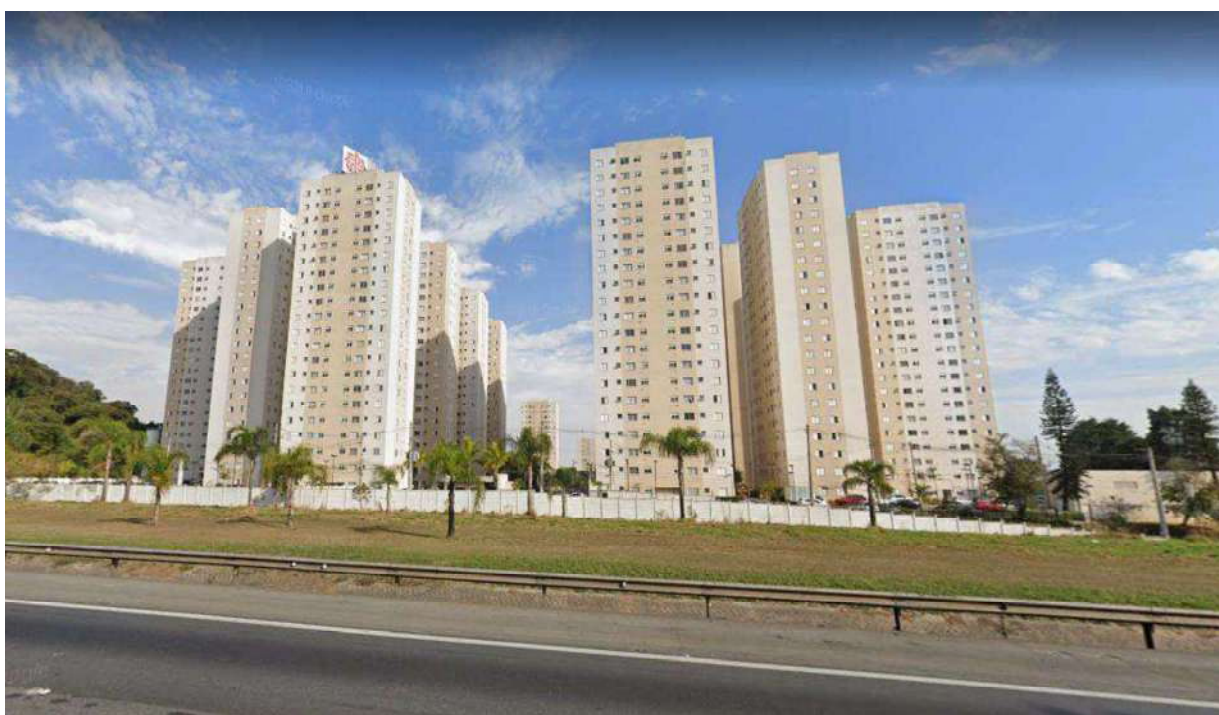
Vista parcial do conjunto de edifícios que compõe o Condomínio Inspire, voltado para a Rodovia Presidente Castelo Branco.
