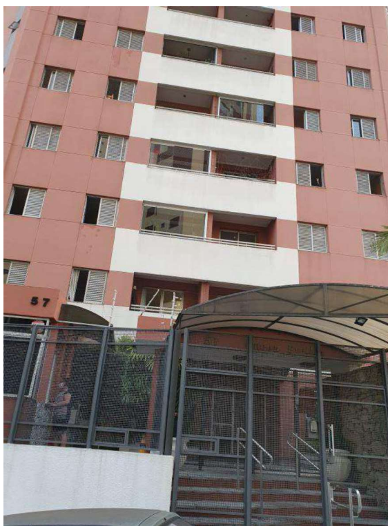
FOTO N° 01 Vista parcial fachada Edifício Queen Evellen
