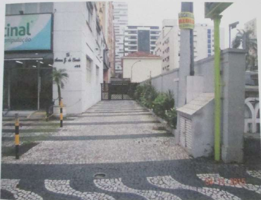
FOTO 06: Vista parcial do recuo lateral direito de quem da avenida olha para o prédio, por onde se tem acesso aos halls social e de serviço, e à garagem de autos nos fundos do terreno.
