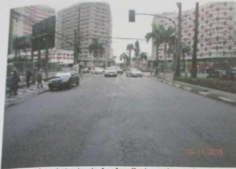
FOTO 03: Vista de trecho da Av. Ana Costa; o observador encontra-se posicionado em frente ao Edifício "Áurea Gonzalez Conde" olhando em direção à Praça Independência (sentido centro-praia).
