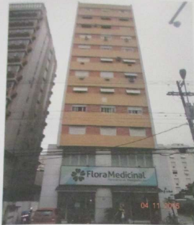
FOTO 05: Vista da fachada frontal do Edifício "Aurea Gonzalez Conde", situado à Av. Ana Costa nº 499.
