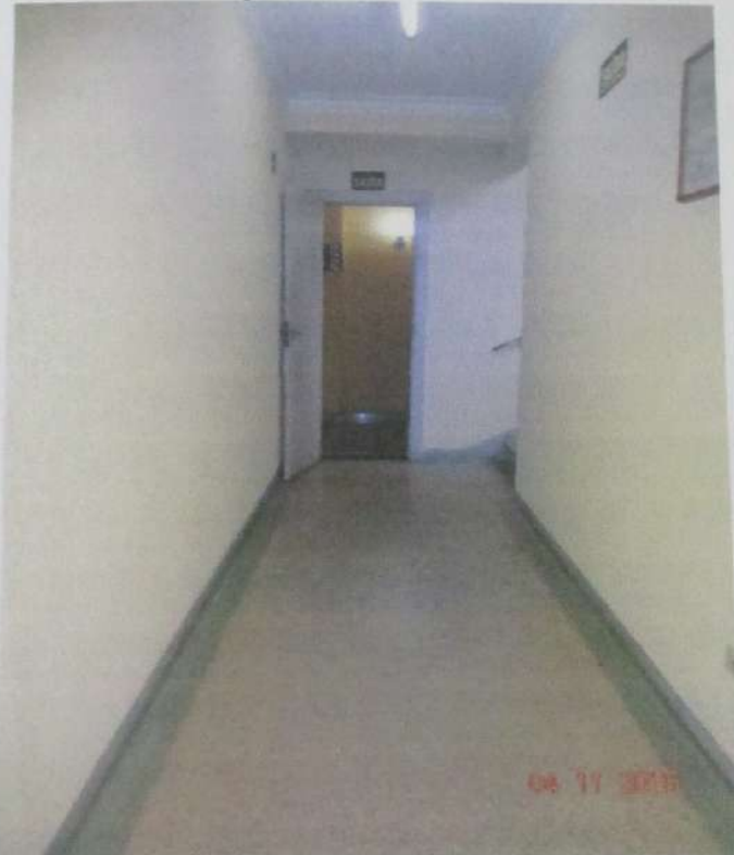
FOTO 12: Vista parcial do hall de ligação entre as entradas social e de serviço no pavimento térreo.
