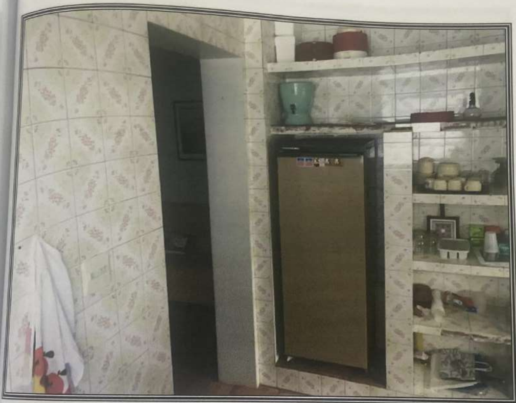
Vista interna do imóvel avaliando, construção antiga.
