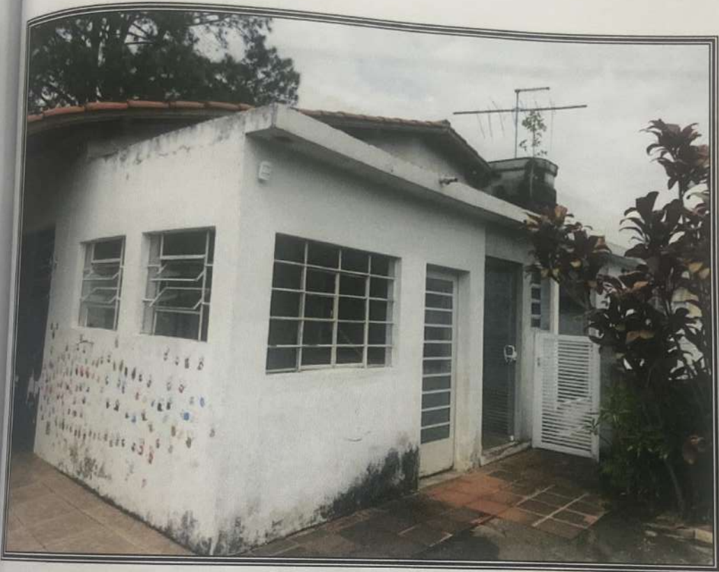
Construção antiga necessitando de reparos.
