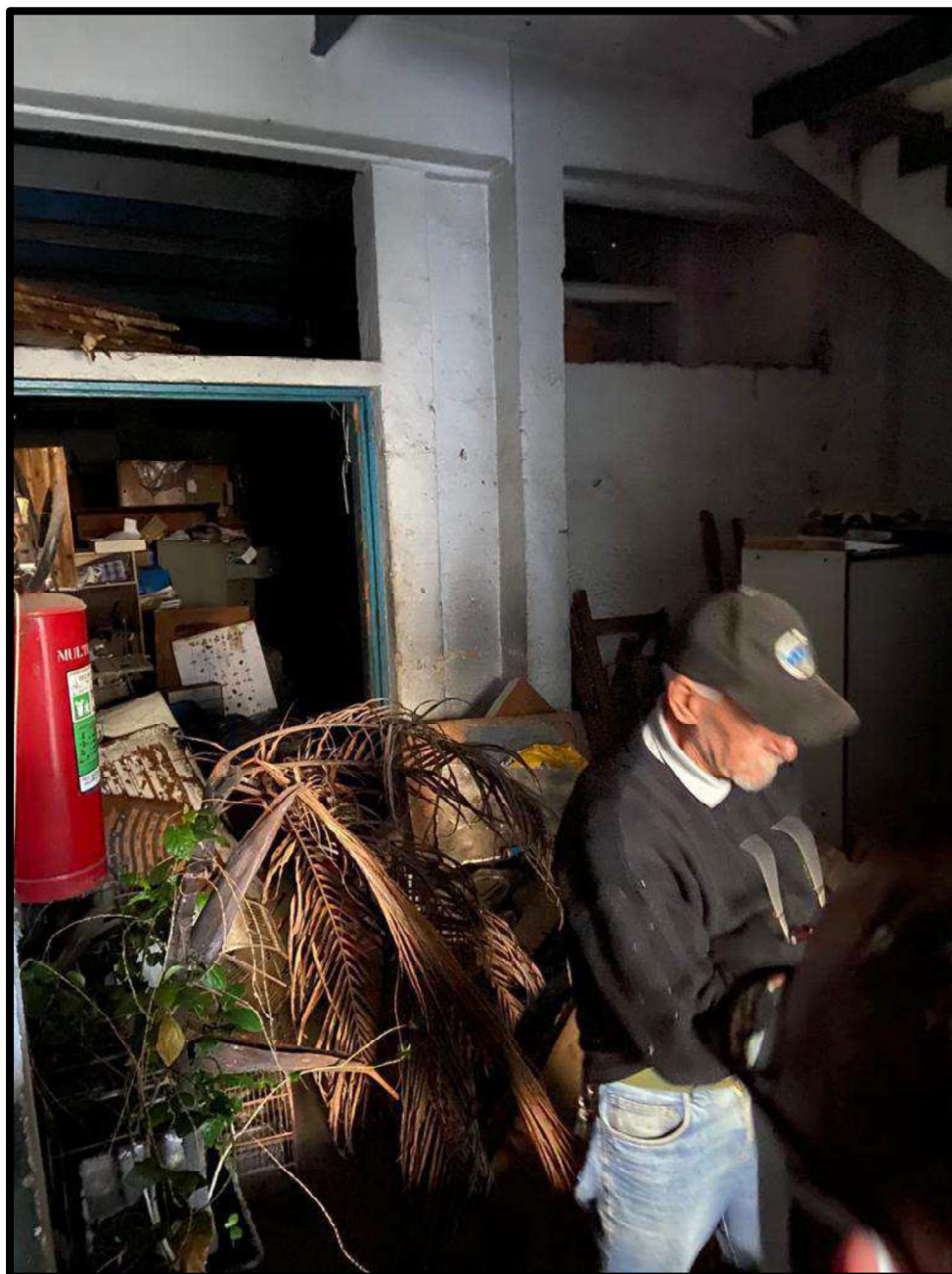
Foto nº 16 – Aspecto interno parcial da edificação de fundos.
