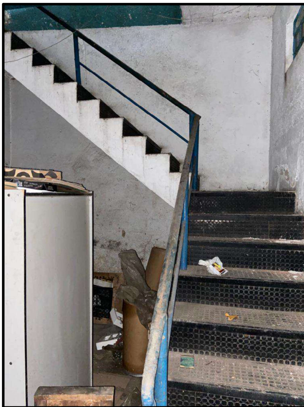
Foto nº 24 – Escada de acesso ao pavimento superior.
