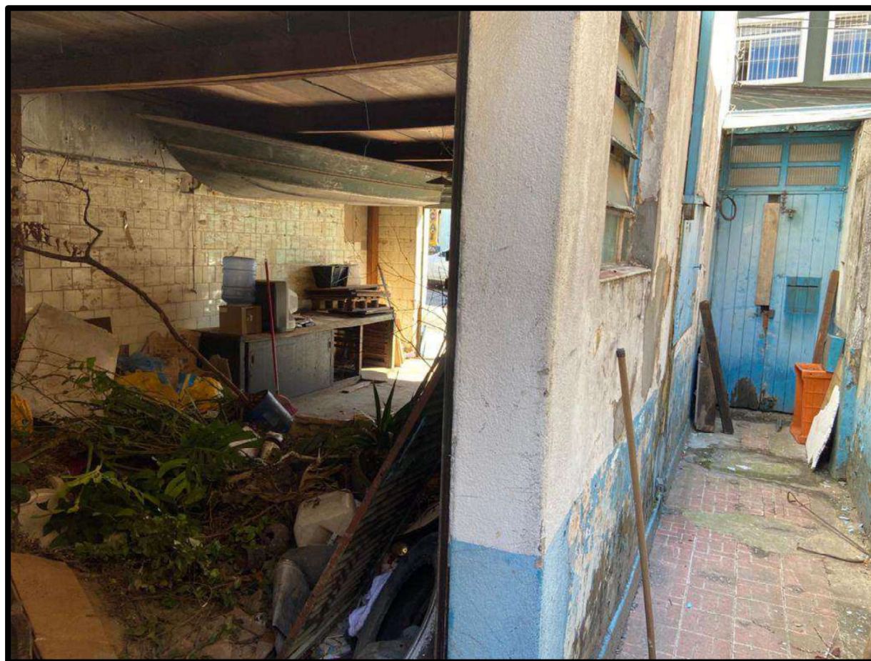
Foto nº 09 – Aspecto parcial do interior da edificação localizada na parte frontal do imóvel.
