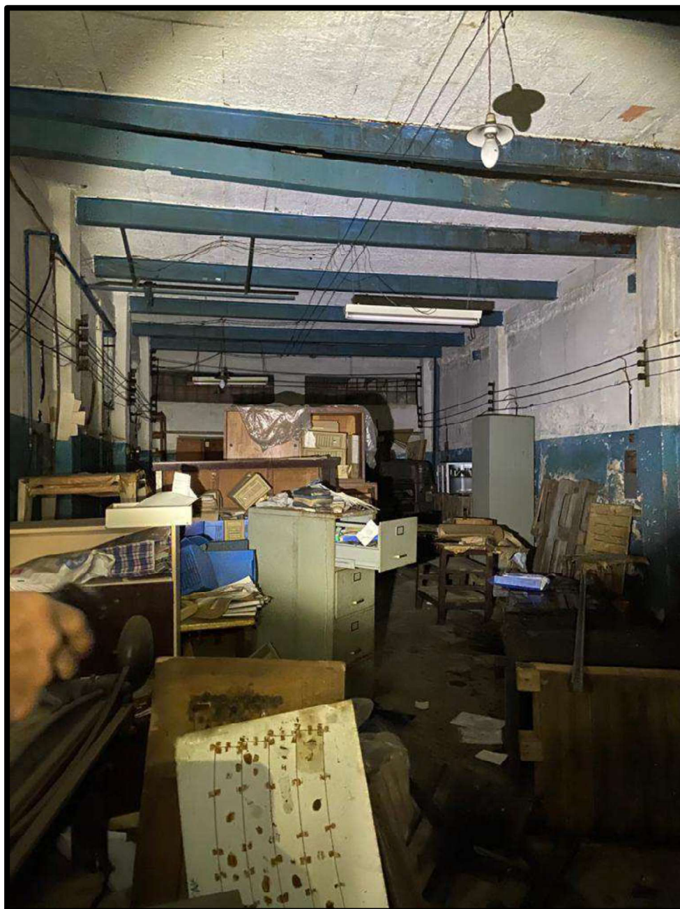
Foto nº 25 – Vista interna do pavimento superior.
