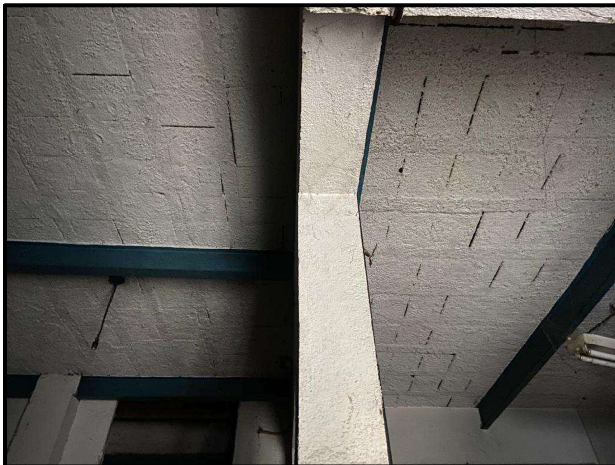
Foto nº 22 – Aspecto da laje pré e do vigamento transversal metálico.
