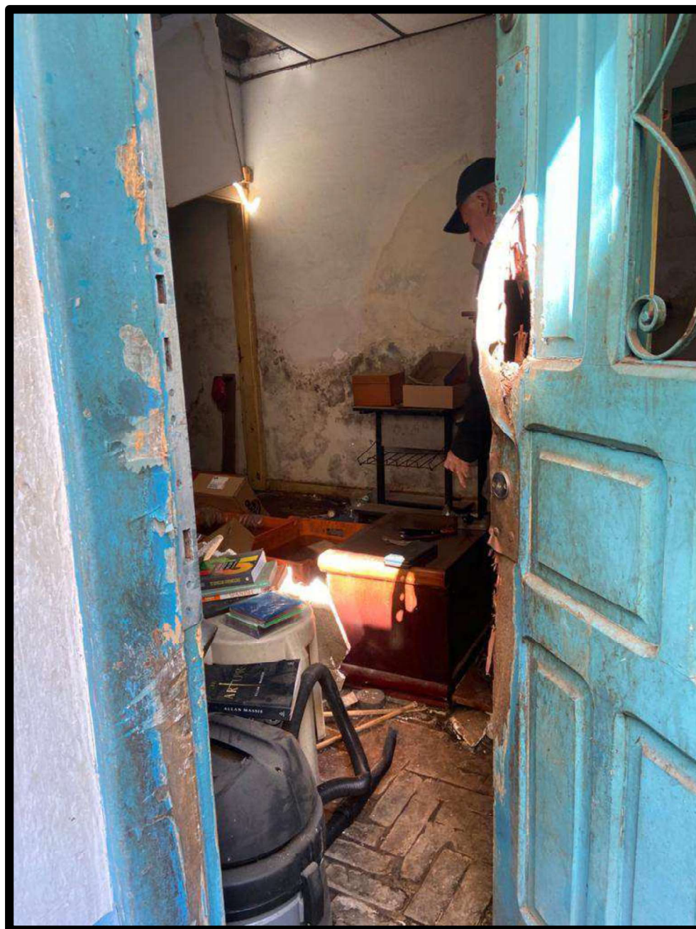
Foto nº 12 – Ilustra a entrada de outro cômodo que compõe a edificação frontal.
