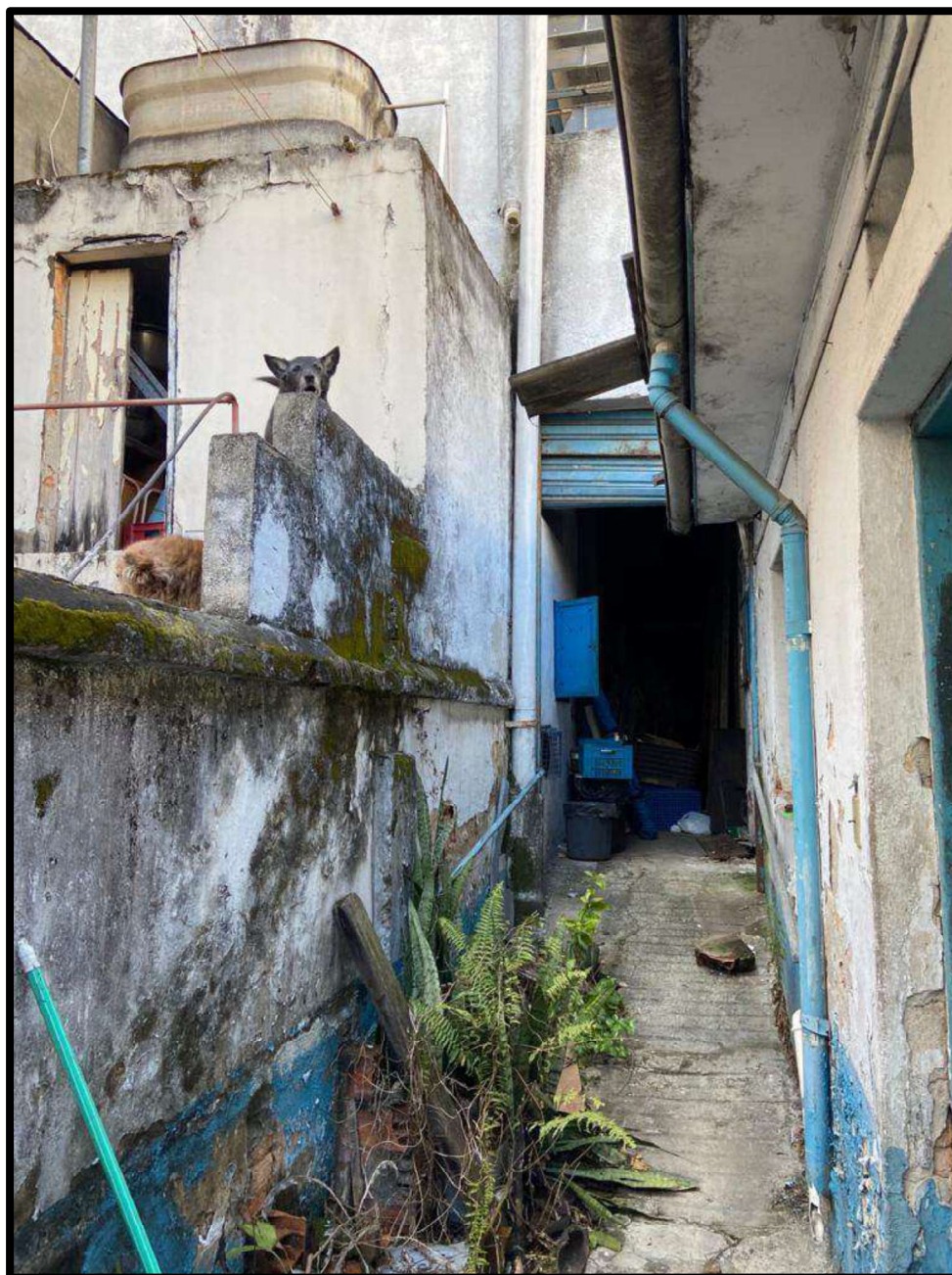
Foto nº 07 – Idem, idem. Observe a porta de entrada para a edificação localizada na parte dos fundos do imóvel.
