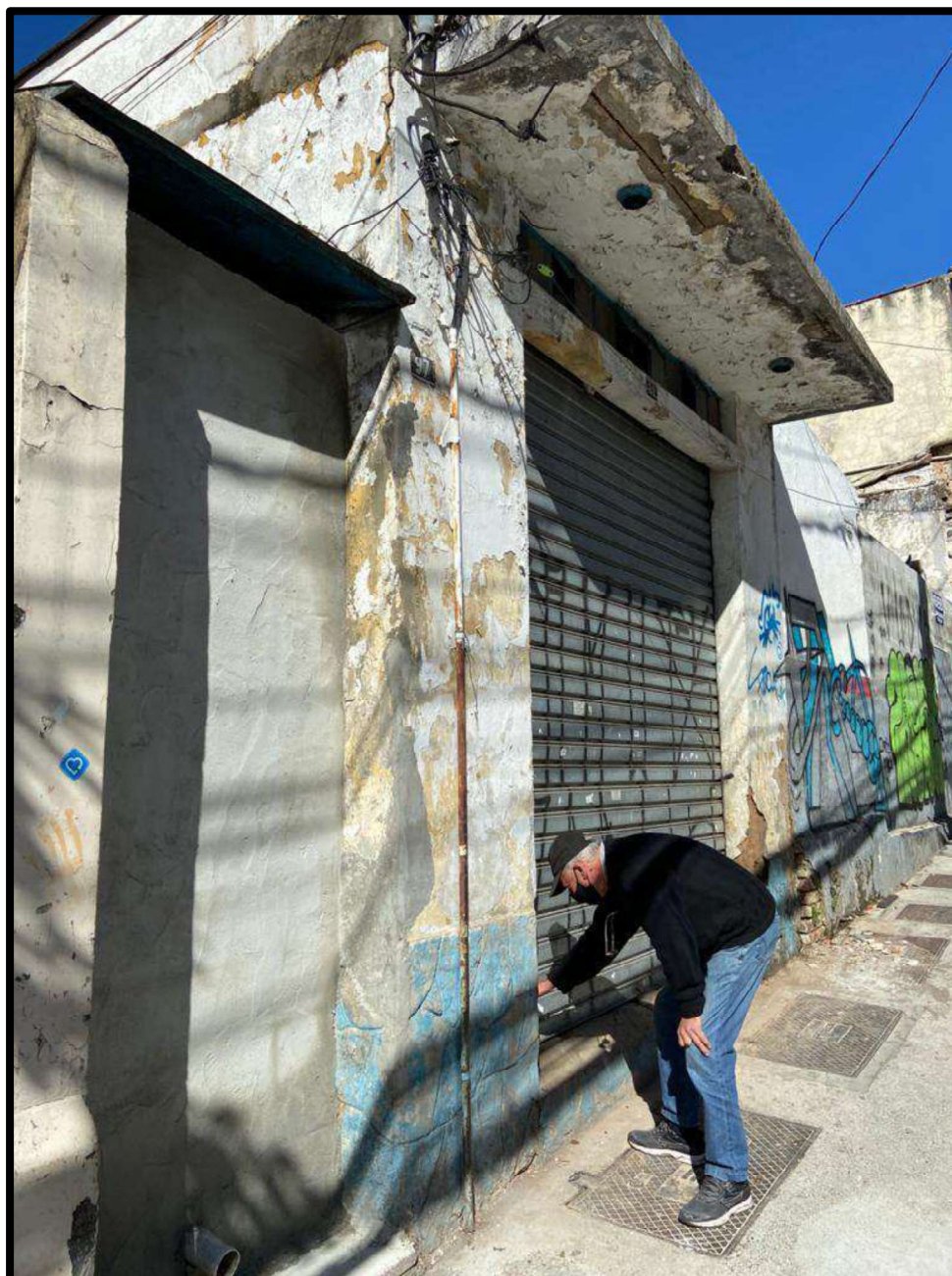
Foto nº 04 – Idem, idem. Observe que o imóvel em questão possui entrada por porta de enrolar de aço.
