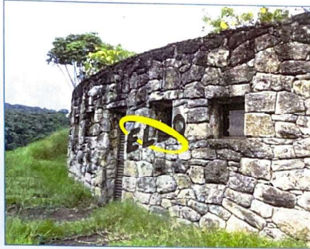
Foto 03 – Entrada da sauna
