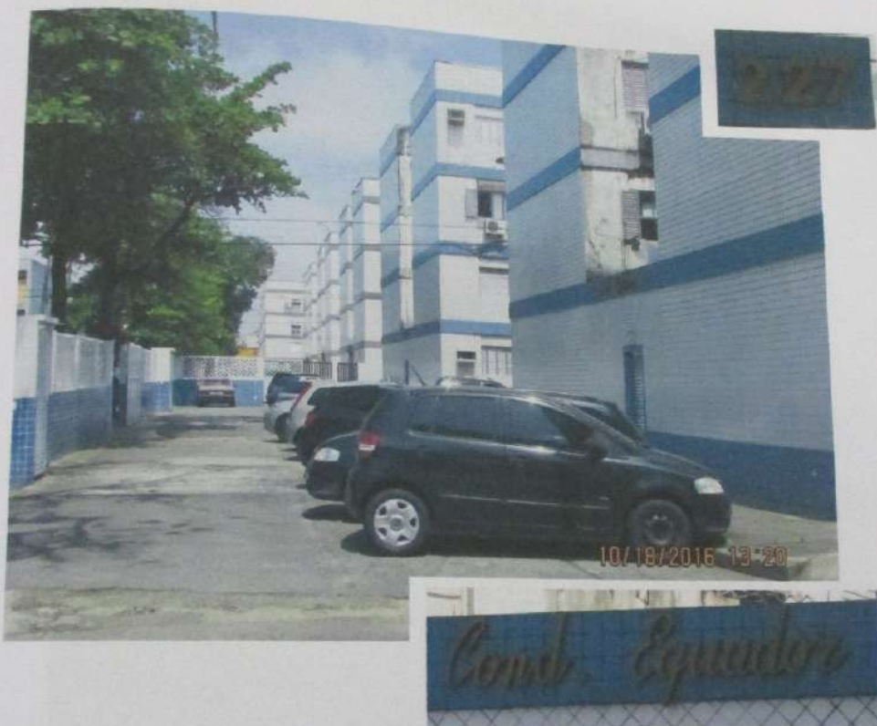
Foto 01 - Vista dos blocos que compõem o condomínio de edifícios, equad
