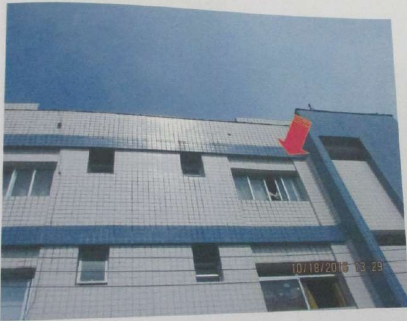
Fotos 03 e 04 - Acesso a escadaria e fachada do apartamento 313.
