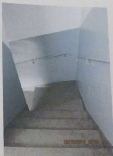
Fotos 05 e 06 - Áreas comuns de escadaria bloco 07.
