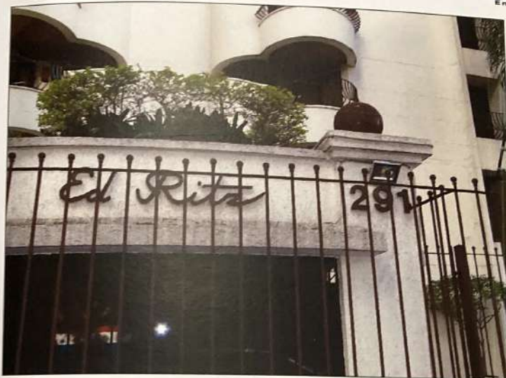
Vista aproximada da identificação existente no edifício, bem como sua numeração.
