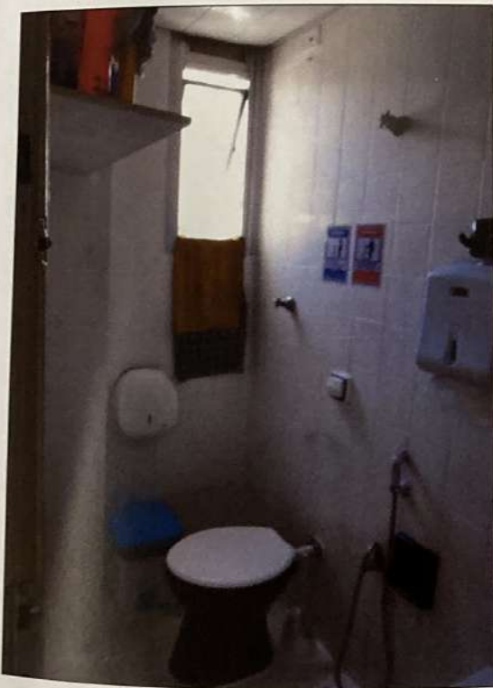
Detalhe fotográfico do segundo banheiro que existe no imóvel.
