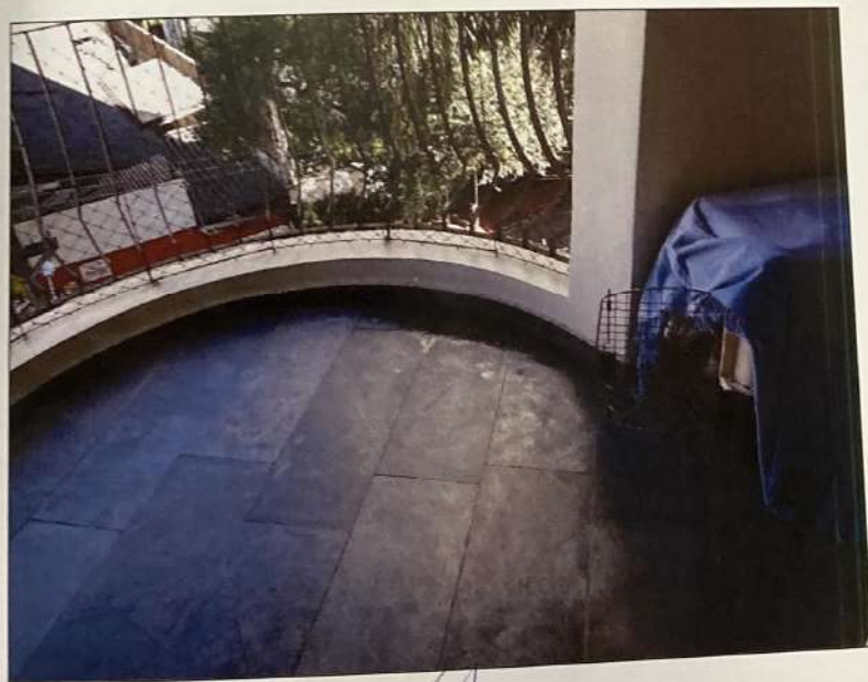
Detalhe do terraço principal.
