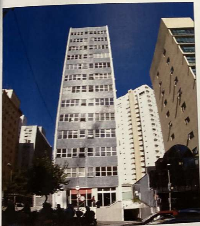
Nova vista da fachada do edifício.
