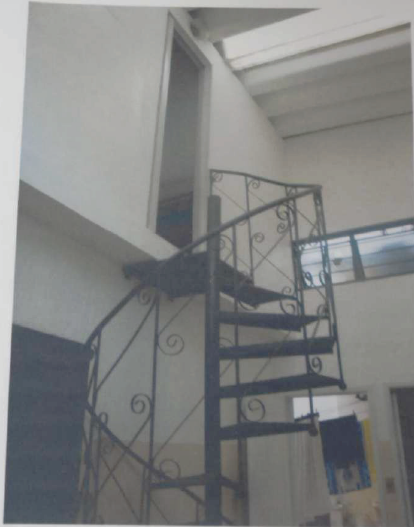
FOTO N. 13 : Cômodo construído sobre o dormitório de fundo, cujo acesso é feito por uma escada de ferro que se encontra localizada na antiga lavanderia.
