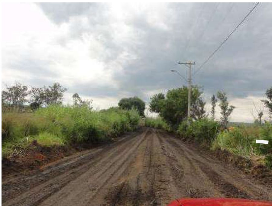
VISTA DA VIA ONDE SE LOCALIZA O IMÓVEL.
