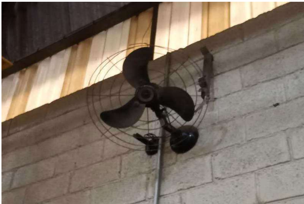
ITEM 2,002 - VISTA DO VENTILADOR DE PAREDE
