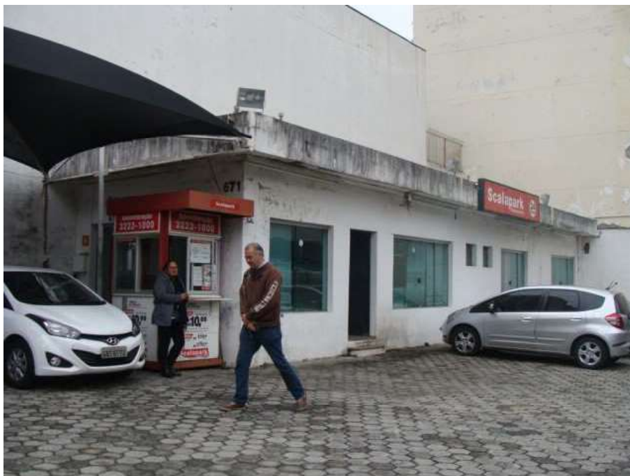
Foto 9. Vista geral do escritório.
