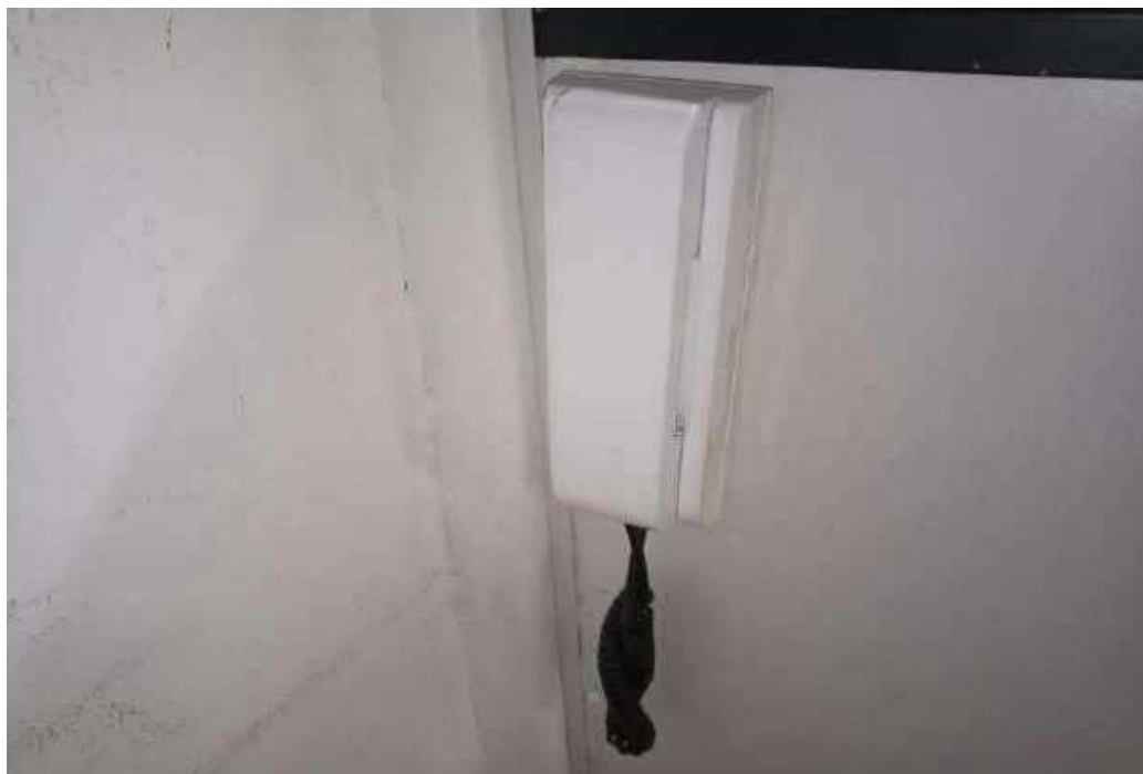
ITEM 2,012 - VISTA DO INTERFONE
