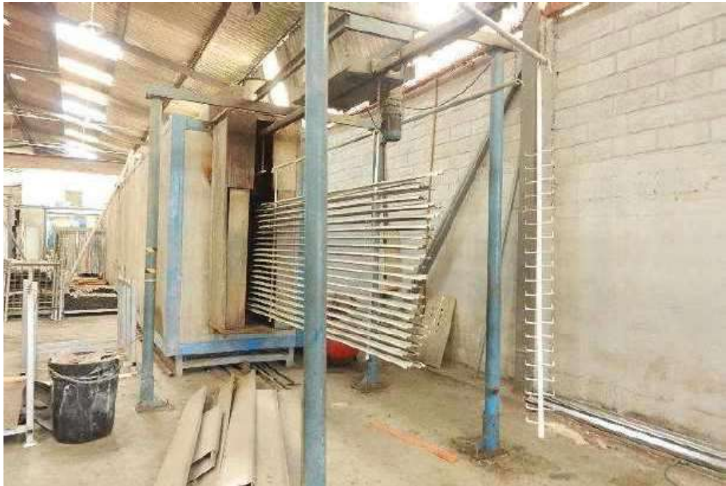
ITEM 1,038 - VISTA DA ESTUFA DE SECAGEM DA LINHA DE PINTURA A PO MARCA: ERZINGER
