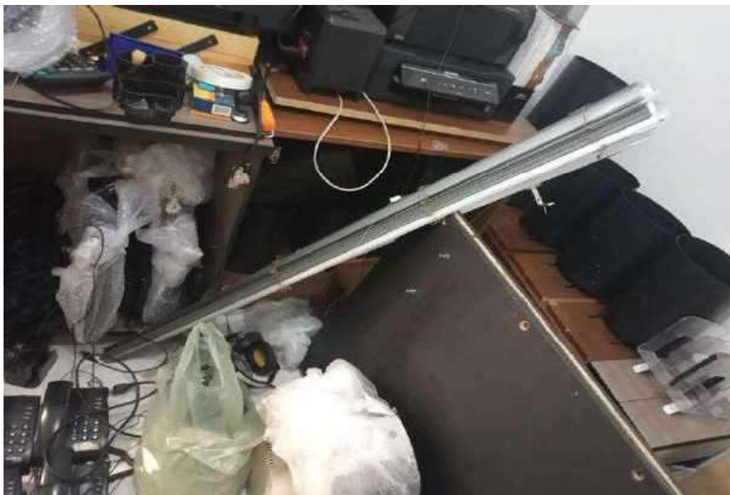
ITEM 2,018 - VISTA DA PERSIANA DE ALUMÍNIO
