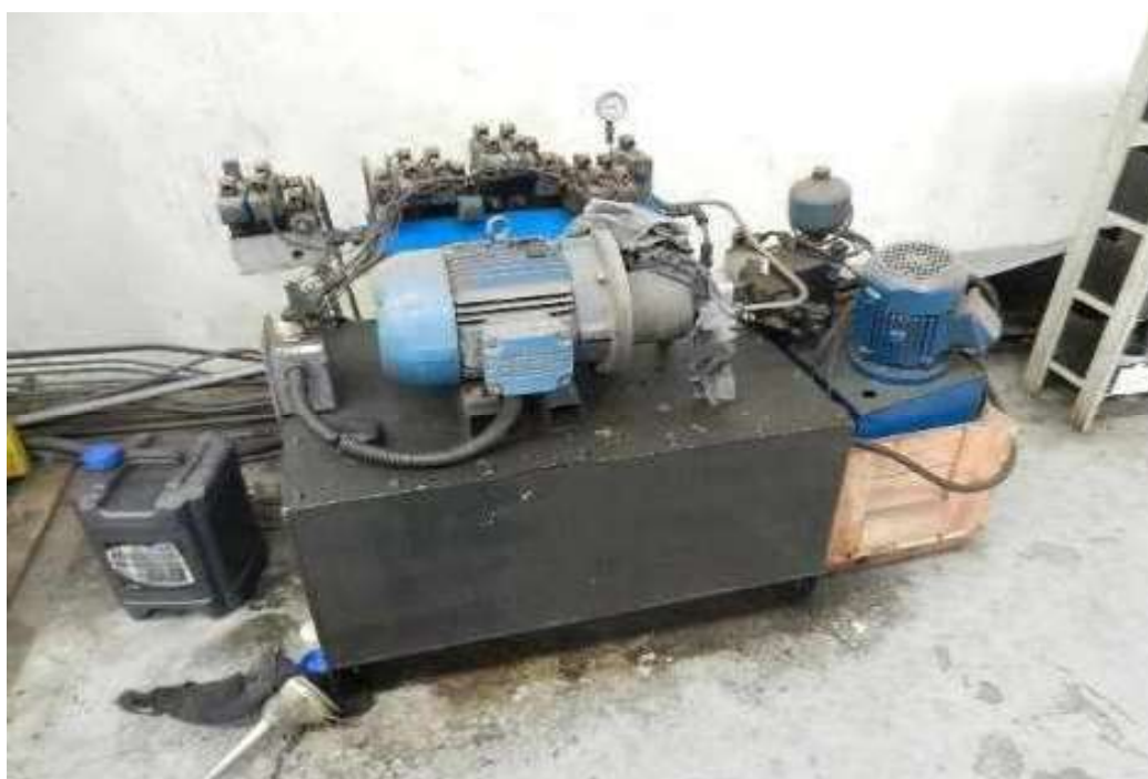
ITEM 1,025 - VISTA DA UNIDADE HIDRAULICA COM MOTOR ELETRICO DE 2 CV
