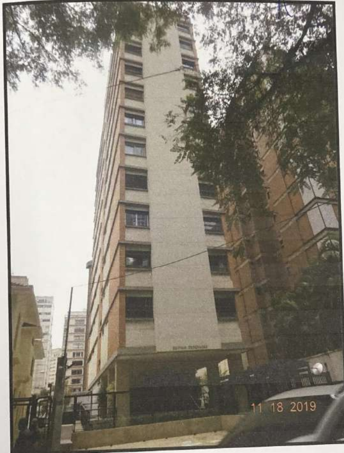
VISTA DA FACHADA DO "EDIFÍCIO ESPERANÇA".
