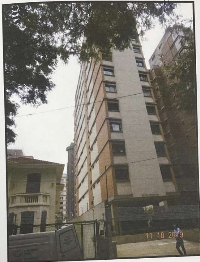
OUTRA VISTA DA FACHADA DO "EDIFÍCIO ESPERANÇA".
