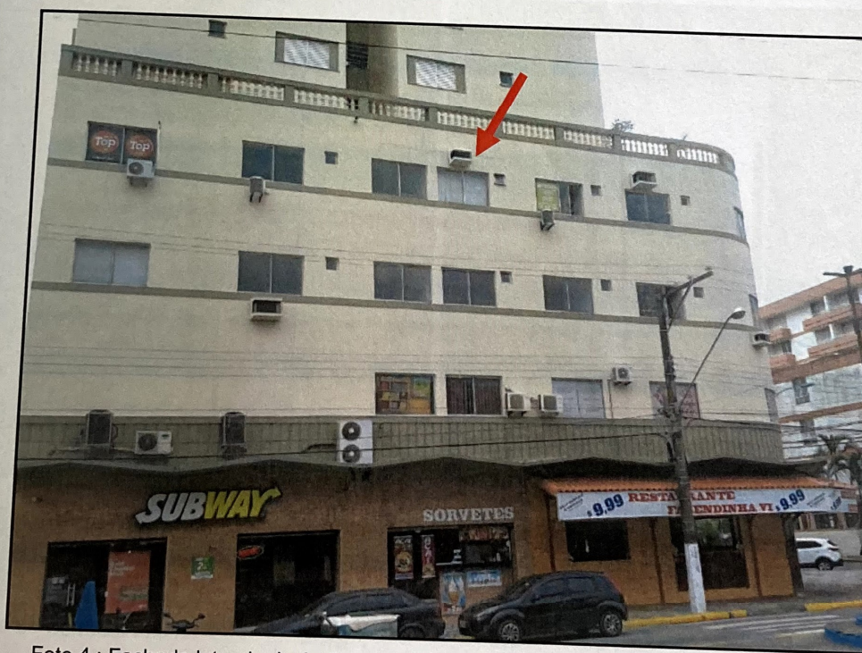
Foto 4 : Fachada lateral – imóvel avaliando ( sala 4 - 3º andar )
