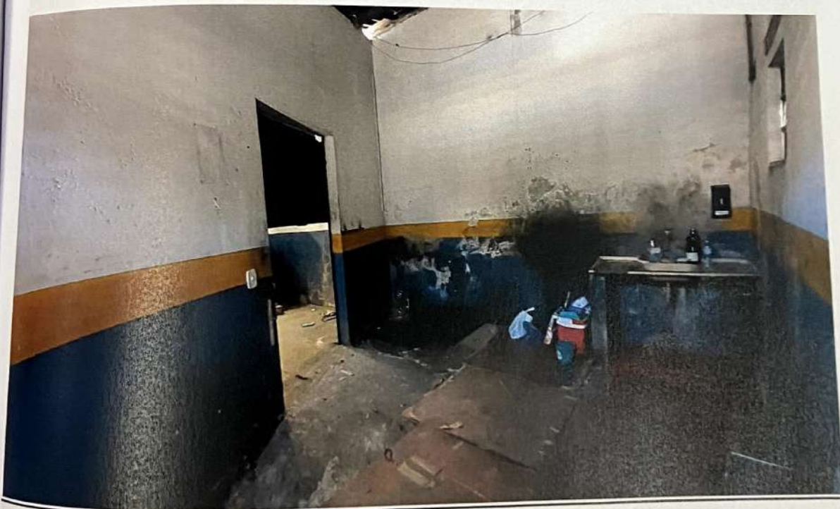
Imagem 08 – corredor de acesso ao depósito e aos banheiros
