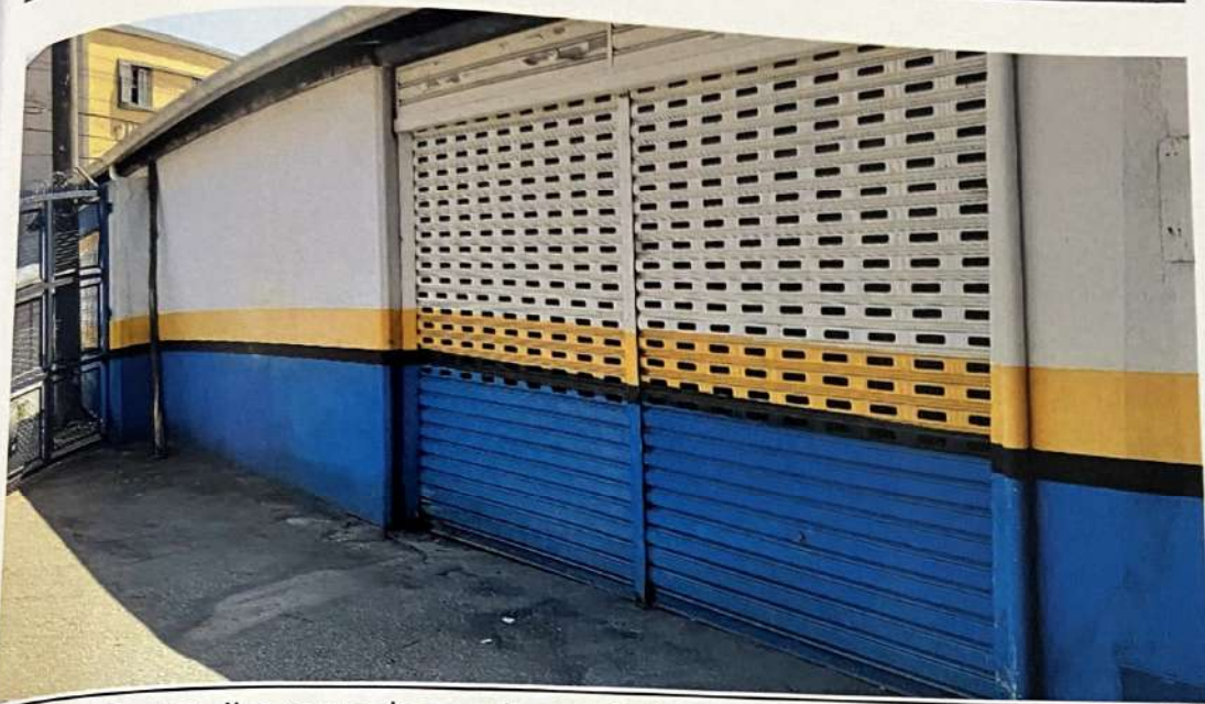
Imagem 07 – detalhe porta de aço de enrolada vazada
