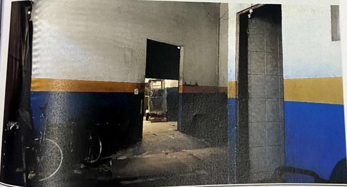
Imagem 09 – corredor de acesso ao banheiro
