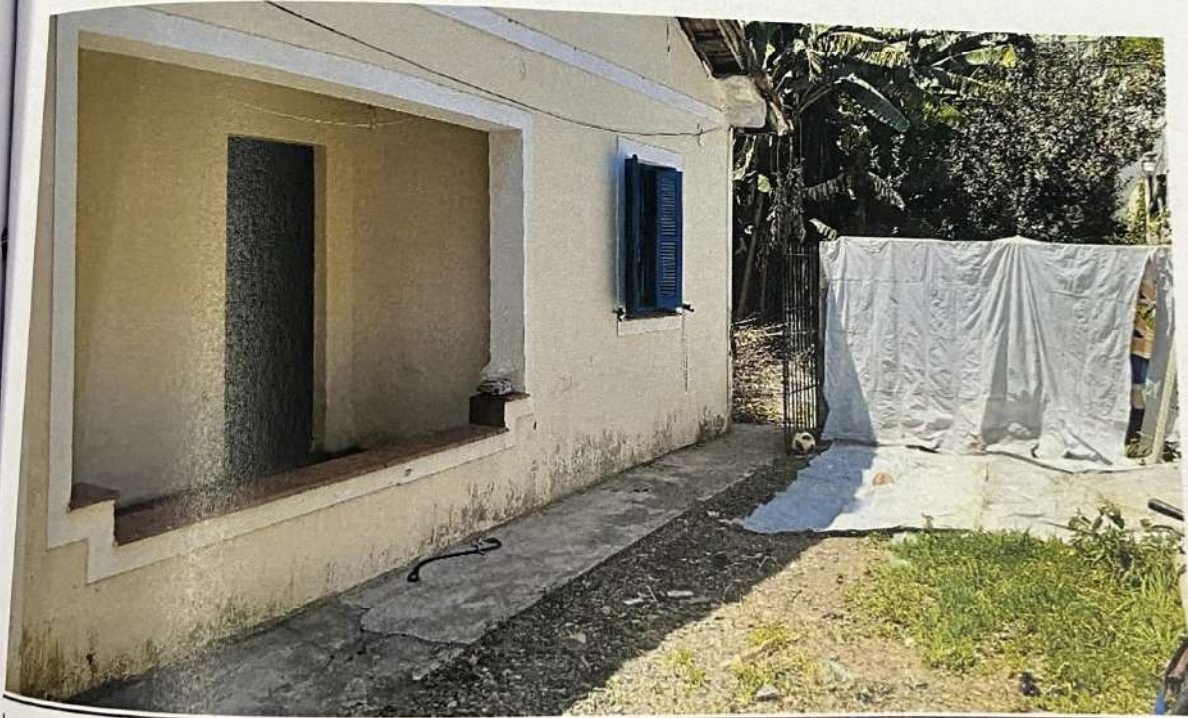
Imagem 18- imagem lateral do imóvel e acesso aos fundos do terreno
