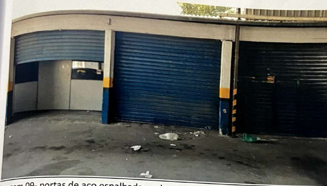
Imagem 09- portas de aço espalhadas pelo galpão construído, ao todo são 4 portas
