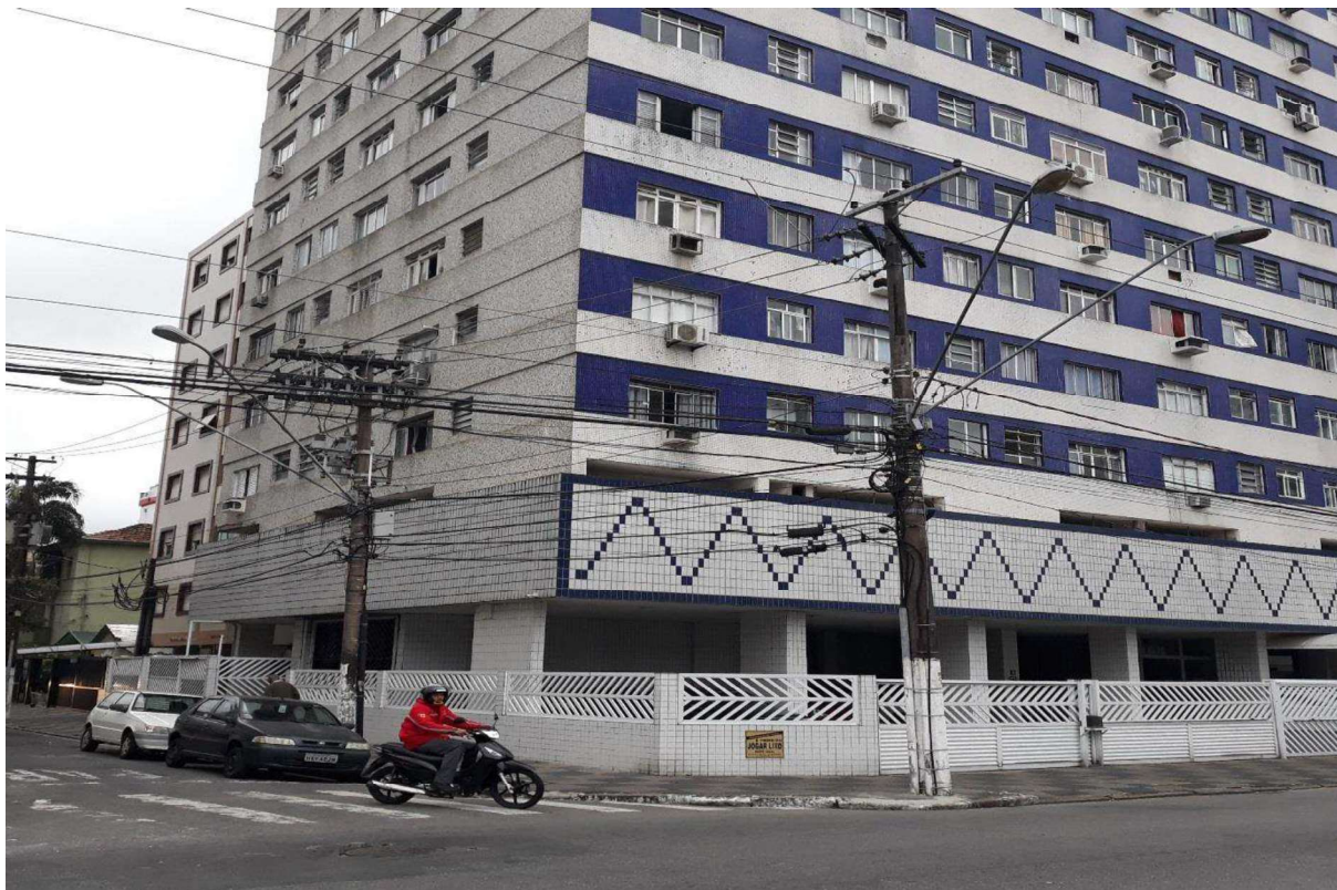
FOTO 03 - Vista parcial do Edifício Presidente na esquina da Avenida Presidente Wilson com a Rua Benedito Calixto.
