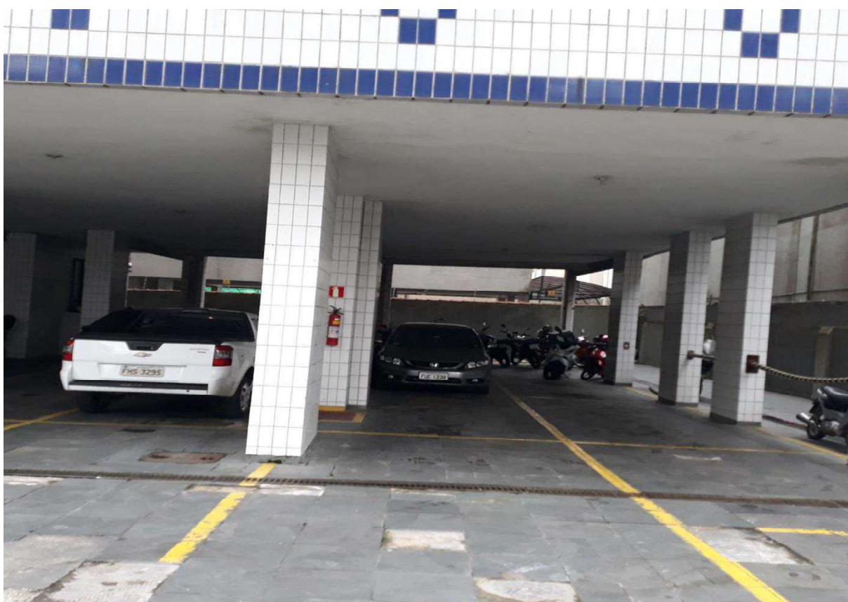
FOTO 05 – Vista parcial do pavimento térreo onde estão parte das vagas de estacionamento do edifício.
