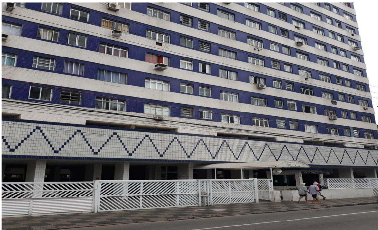
FOTO 01 – Vista parcial da fachada principal do Condomínio Edifício Presidente.
