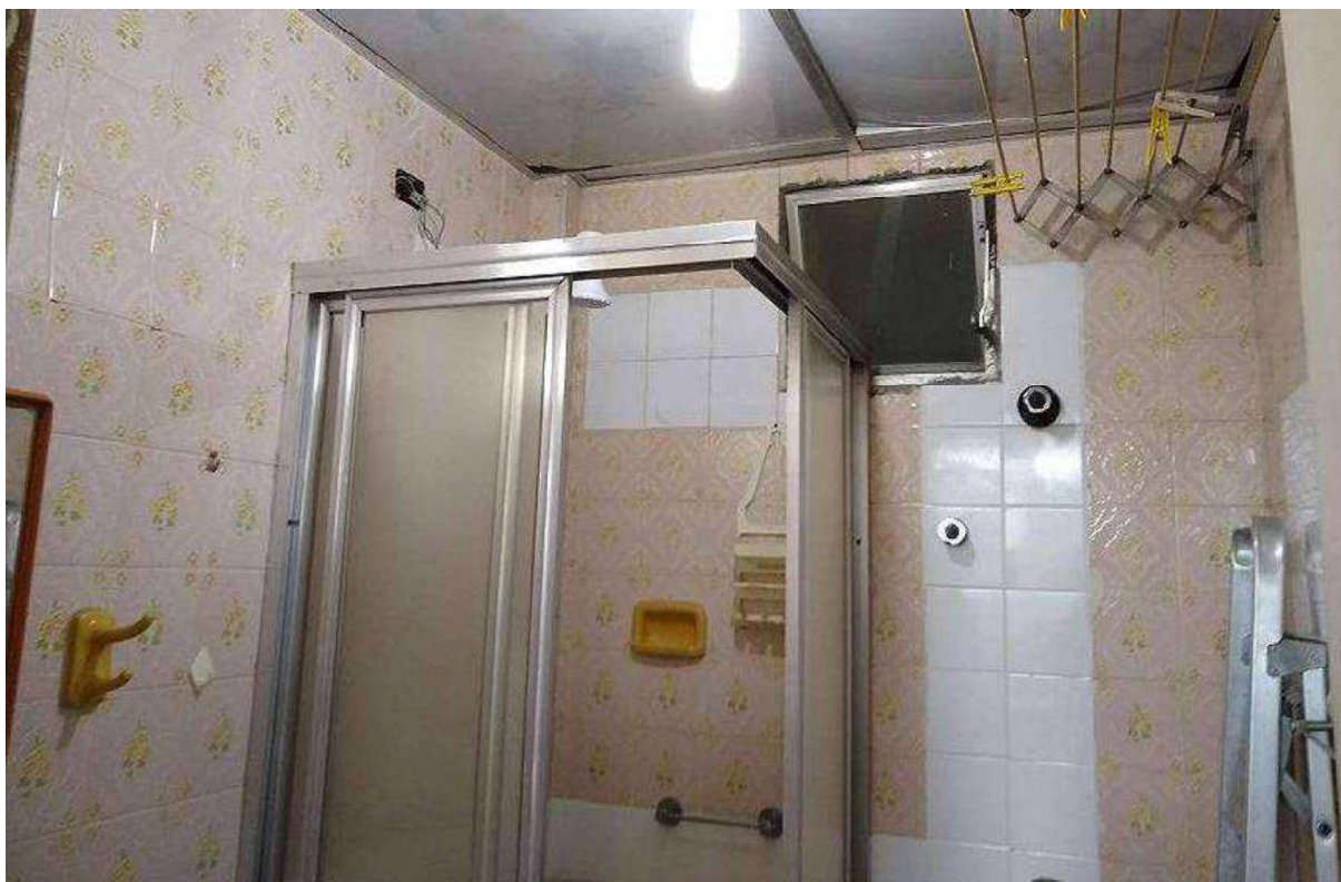
FOTO 12 – Vista Parcial do interior de imóvel similar (banheiro).
