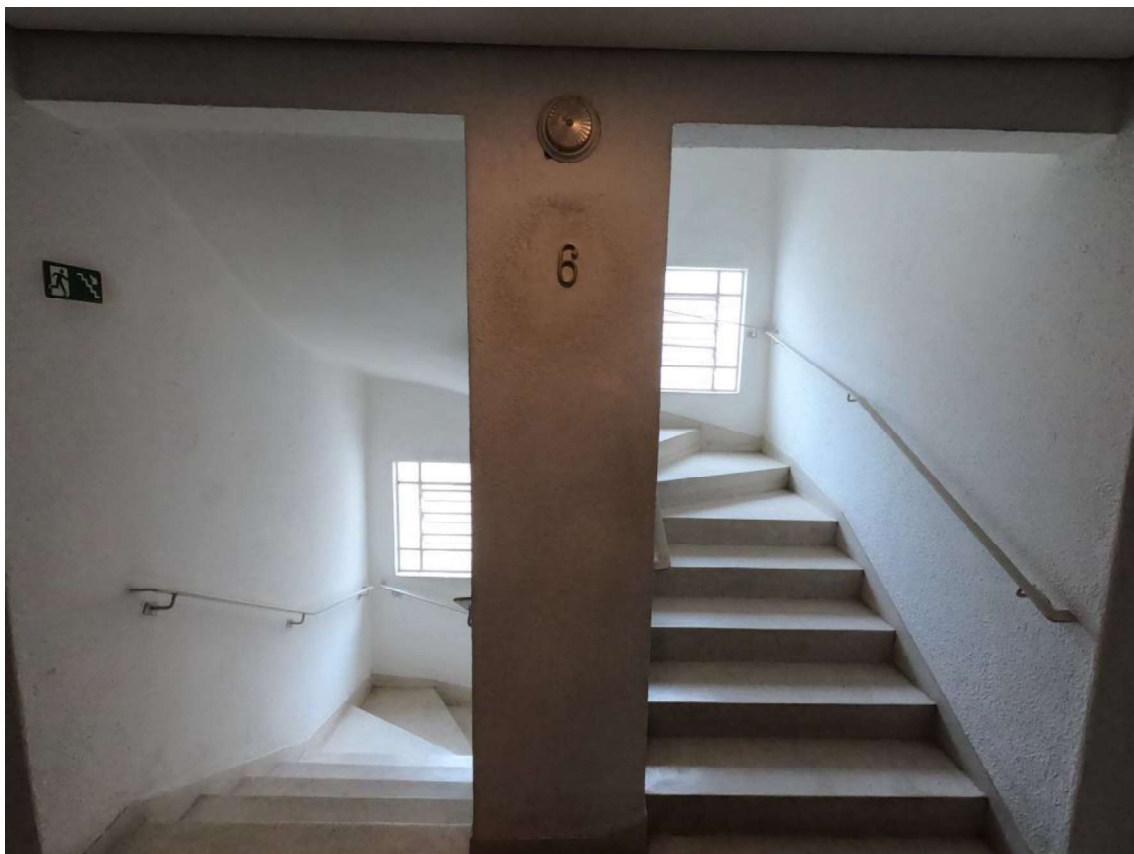
Foto 14. Escadas no 6ª andar.
