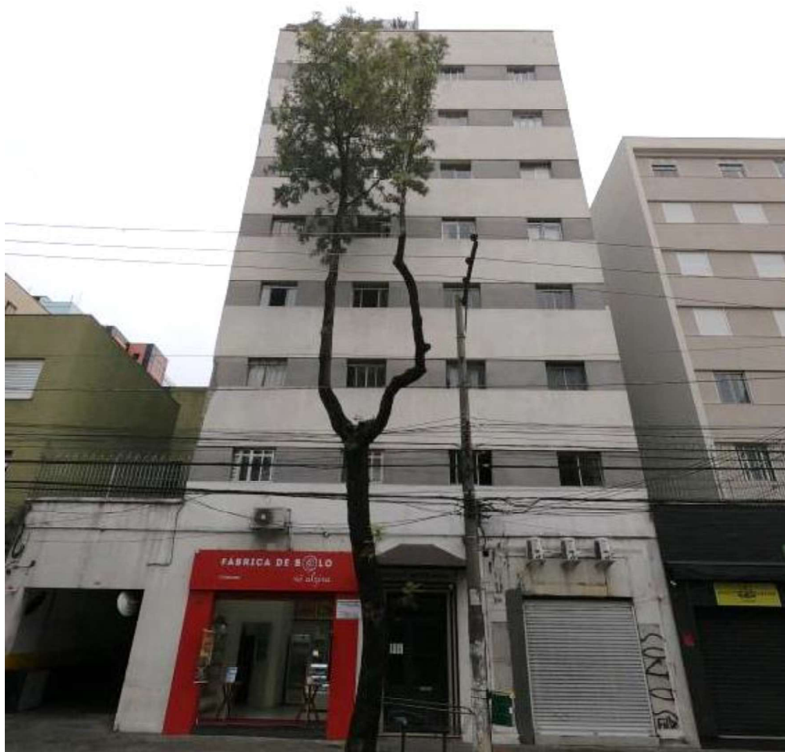
Foto 1. Frente do Edifício.
