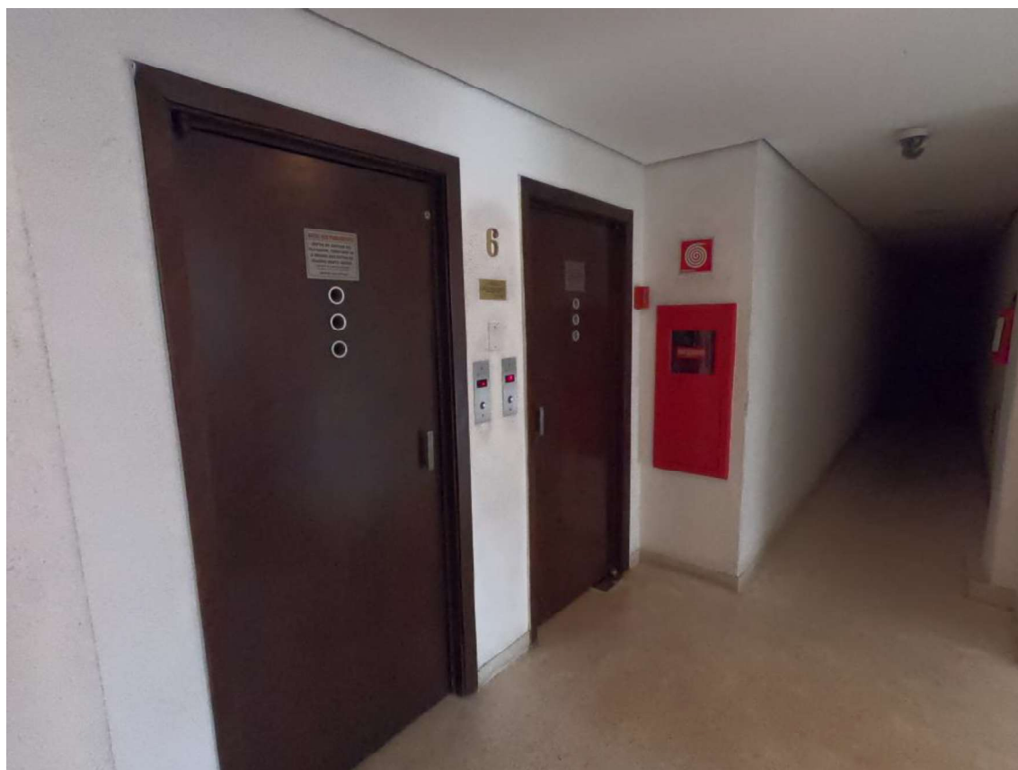
Foto 13. Elevadores no 6º andar.
