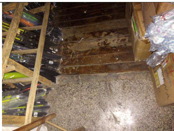
Foto 22 – piso mezanino, madeira e concreto.
