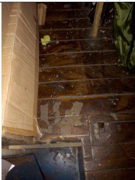
Foto 17 – piso de madeira mezanino.
