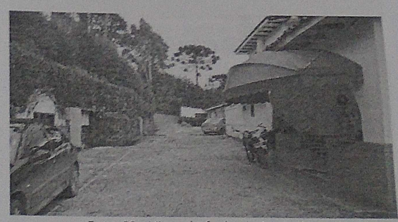
Foto 62- Vista da fachada frontal
