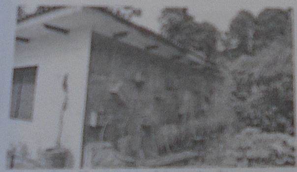
Foto 47 - Vista lateral da construção
