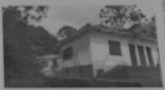
Foto 46 - Vista lateral da construção
