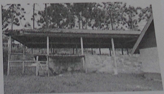
Foto 44 – Vista lateral do galpão
