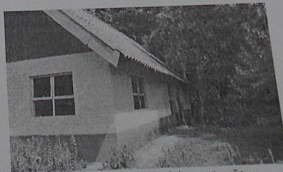
Foto 38 – Vista Lateral da construção
