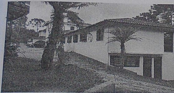
Foto 22 – Vista do acesso da construção principal
