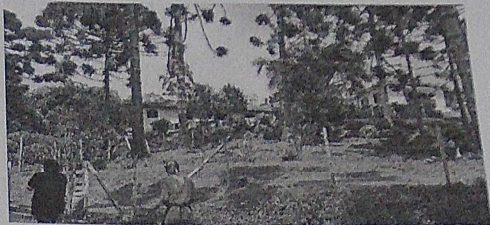
Foto 19 – Vista da Construção Principal
