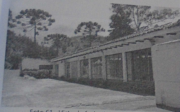
Foto 61- Vista da fachada frontal
