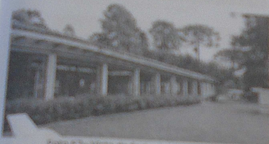
Foto 67- Vista da fachada
