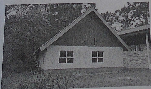
Foto 37 – Vista frontal da construção
