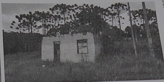
Foto 36 – Vista do depósito.
