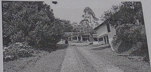
Foto 21 – Vista do Apartamento Externo
